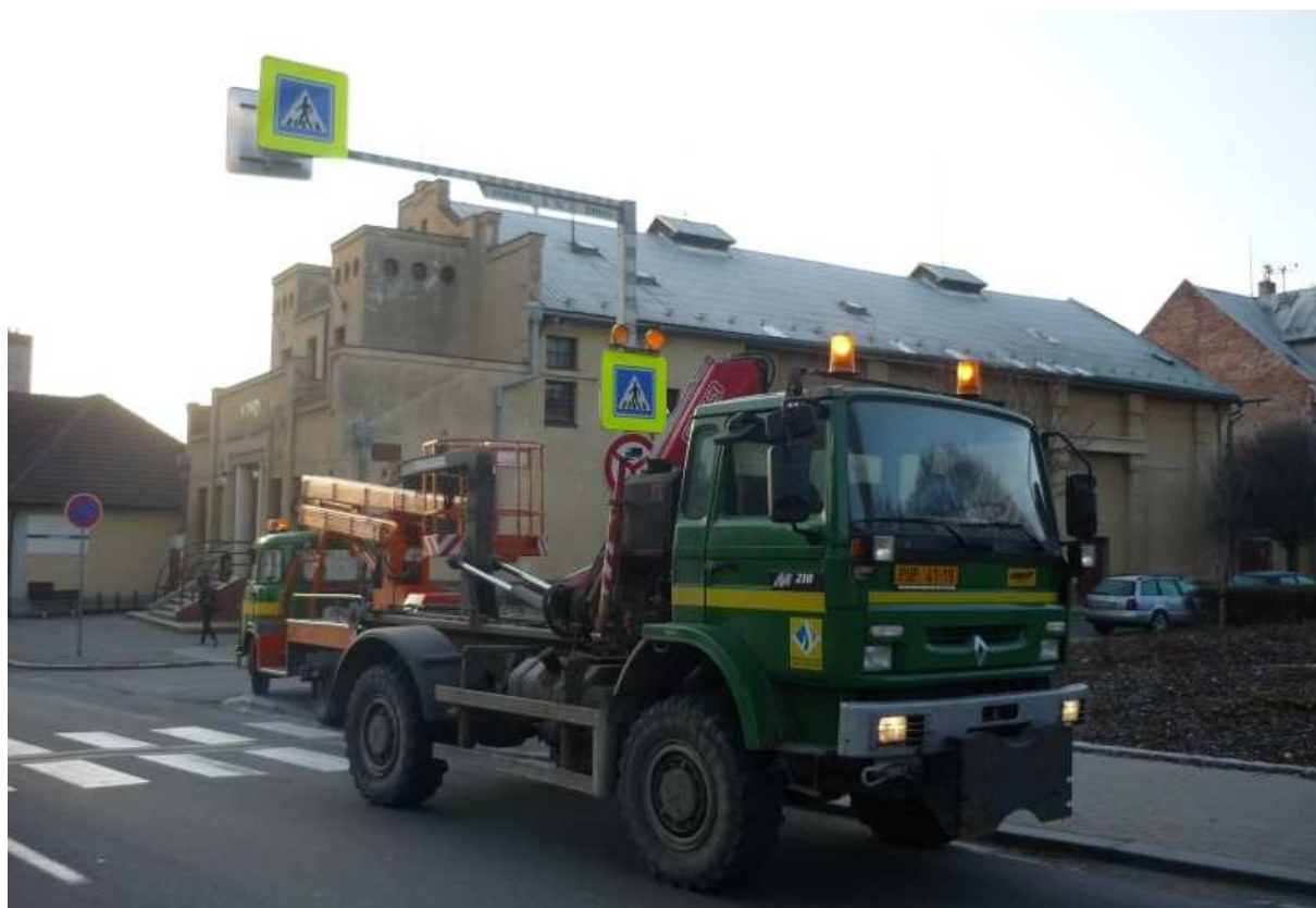
Obr. 1: Demontáž dopravního značení a výložníku
