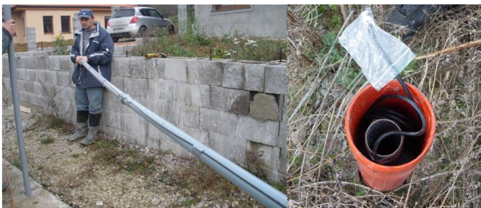
Obr. 7 Inštalácia koaxiálneho kábla do vrtu J1
