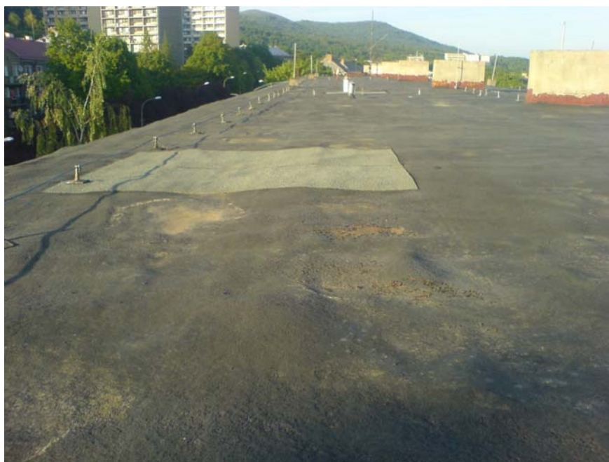
Obr. 16: Pohled na střešní plášť
