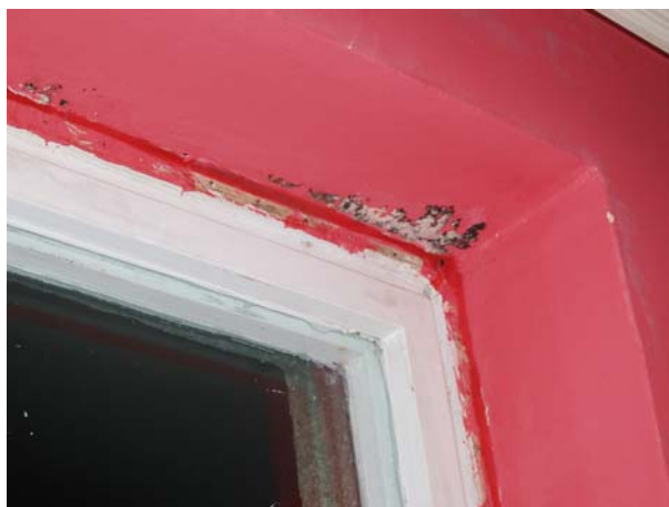
Obr. 3: Ostění okna s výskytem mikromycet
