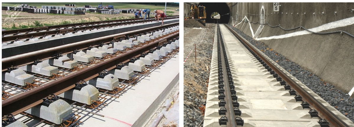
Obrázek 73 Vlevo konstrukce pevné jízdní dráhy na trati Rudoltice – Třebovice před zmonolitněním [152]. Vpravo výstavba konstrukce pevné jízdní dráhy ve Střelenském tunelu [153].
