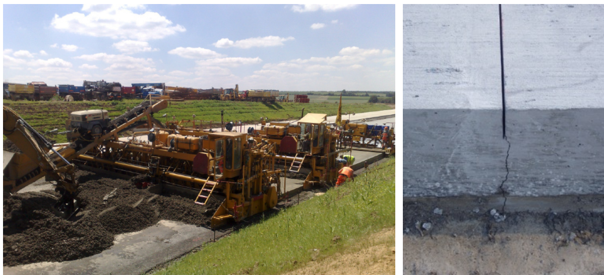
Obrázek 30 Vlevo pokládka dvouvrstvého CB krytu [84], vpravo proříznutá spára v CB krytu [85].
