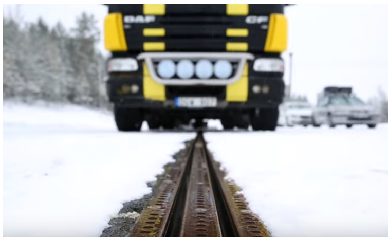
Obrázek 7 Test prvního úseku elektrifikované silnice ve Švédsku (cca dvoukilometrový úsek mezi Stockholmem a Arlandou) [26].
