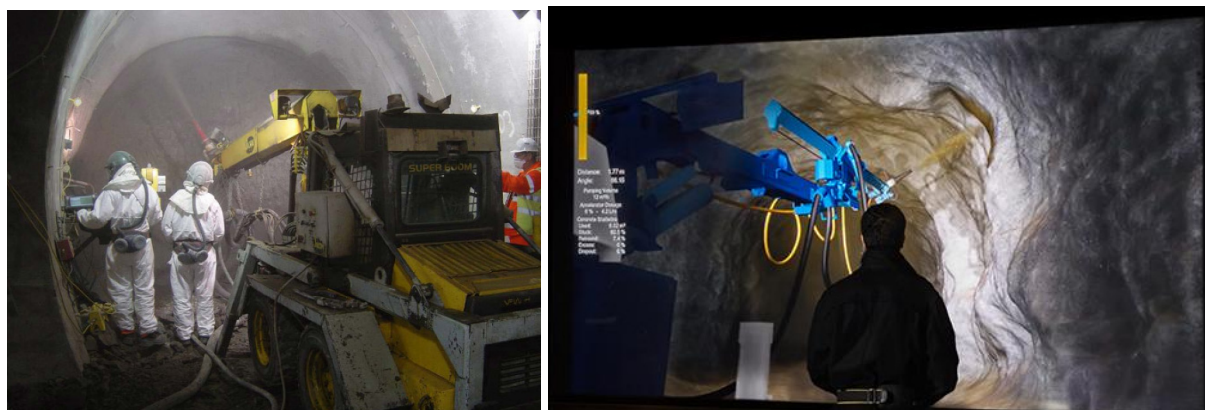
Obrázek 66 Vlevo nástřik betonu metodou LaserShell v praxi [143], vpravo 3D simulátor pro výcvik obsluhy trysky (zdroj: www.edvirt.com ).
