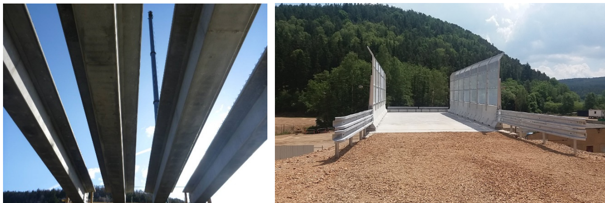
Obrázek 109 Most v lomu Třebnůška. Vlevo osazené Omega nosníky, vpravo hotová konstrukce [193].
