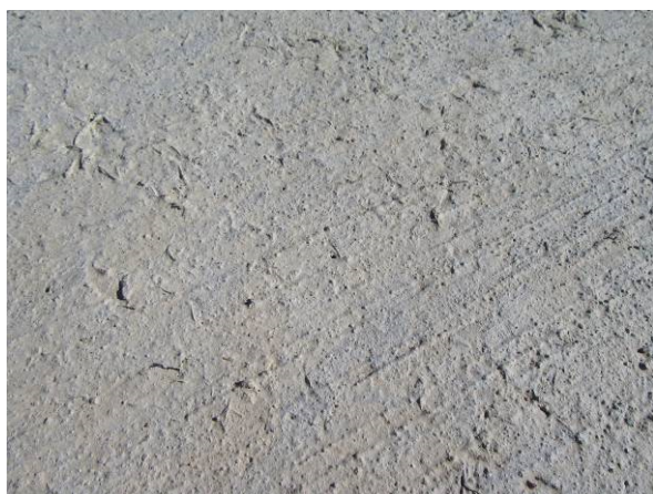
Obrázek 82 Povrch přímo poježděné mostovky z vláknobetonu po uvedení do provozu (vlevo bod B01, vpravo bod B04).
