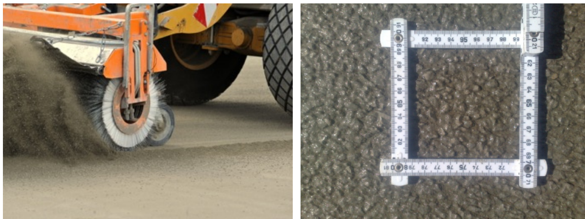
Obrázek 36 Vlevo kartáčování povrchu, vpravo výsledný povrch s obnaženým kamenivem [84].
