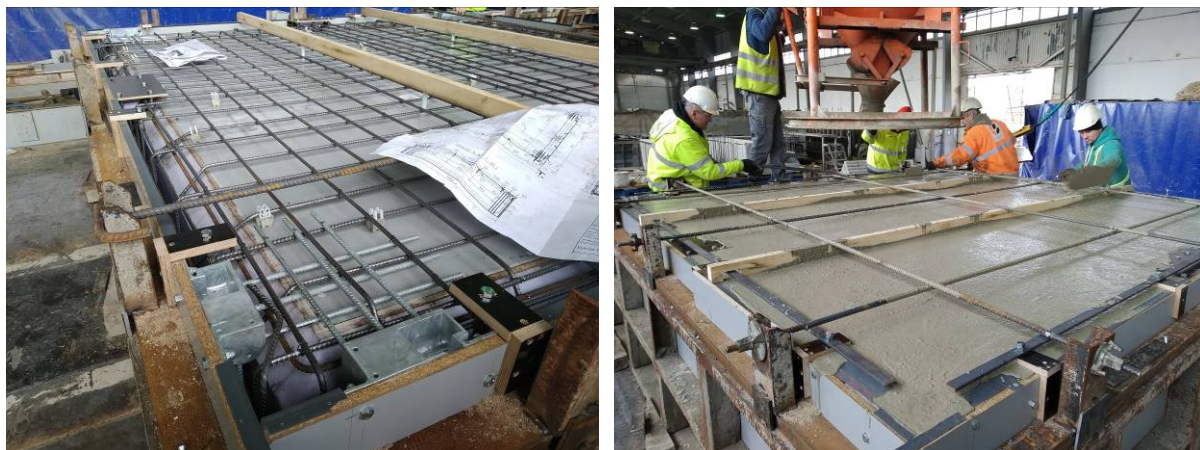
Obrázek 134 Vlevo připravené bednění s výztuží, vpravo betonáž prototypu.
