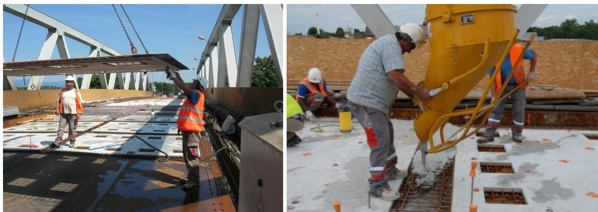
Obrázek 49 Vlevo ukládka prefabrikovaných desek, vpravo zmonolitňování spřahujících pruhů a kapes [115].
