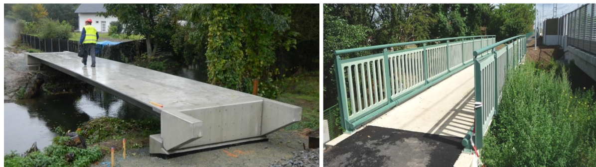
Obrázek 43 Lávka z UHPC přes Opatovický kanál [111].
