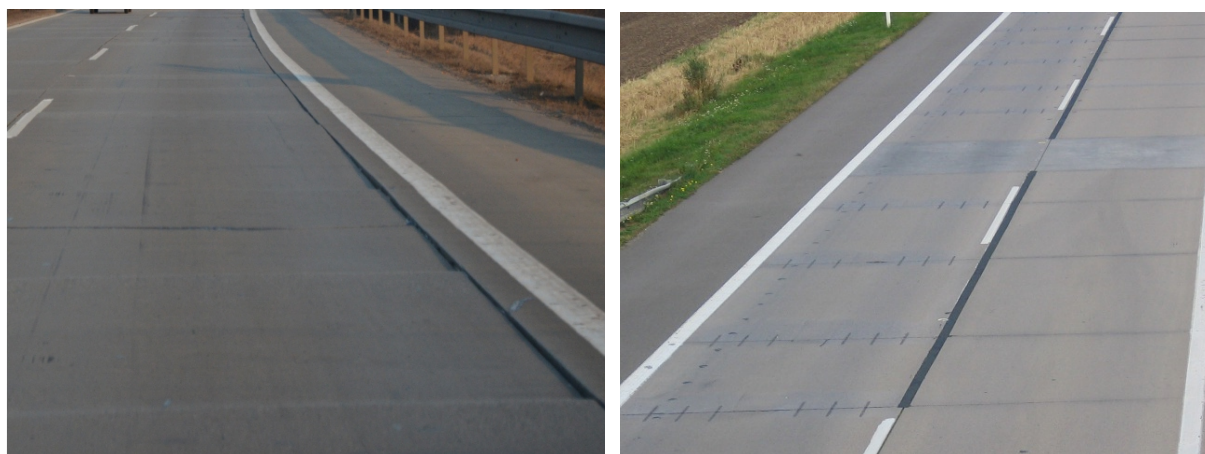
Obrázek 29 Vlevo schůdky ve spárách na D1 (u Rousínova), vpravo dodatečně kotvené spáry na D2 (za Brnem) [83].
