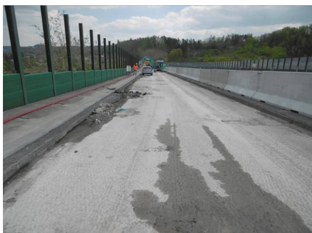
Obrázek 96 Vlevo mostovka po odfrézování horní vrstvy. Vpravo zkušební úseky nabetonávky.
