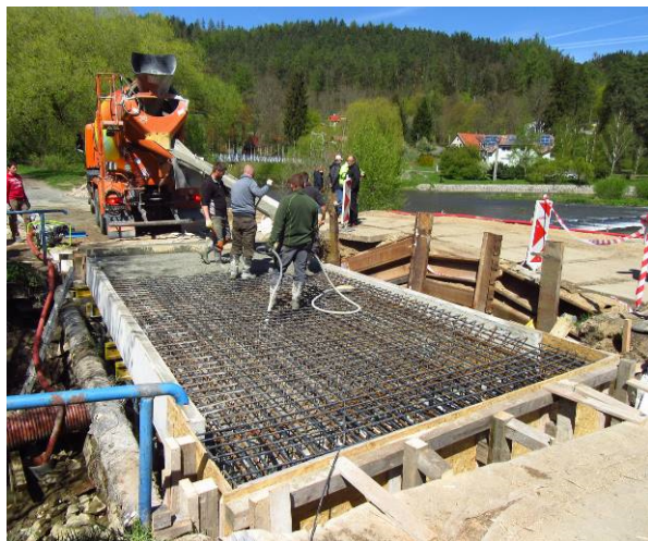
Obrázek 78 Vlevo celkový pohled na most před zhotovením monolitické dobetonávky z vláknobetonu. Vpravo detail výztuže, horní výztuž desky je opatřena ochranným termoplastickým povlakem.
