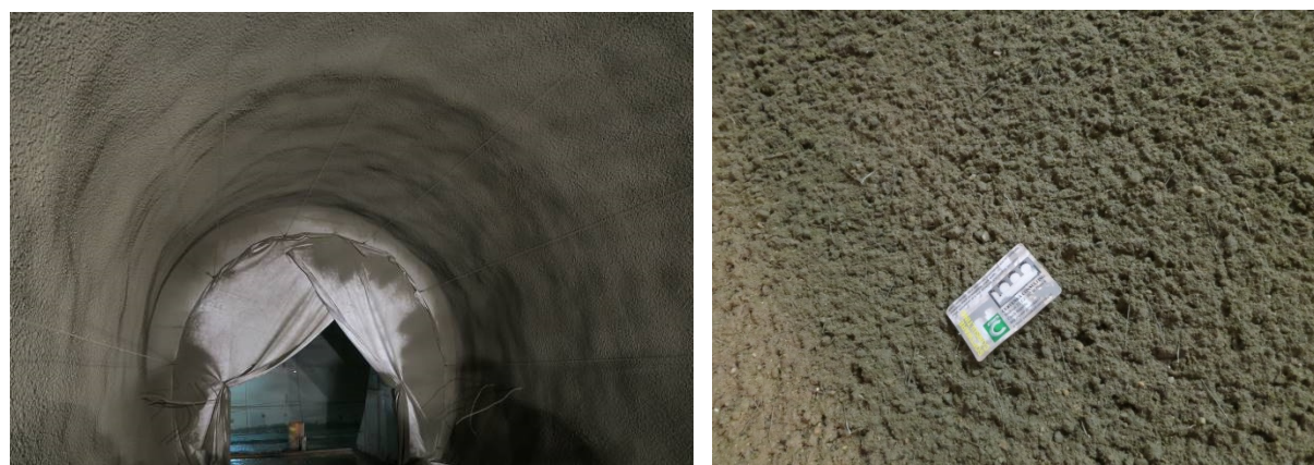
Obrázek 67 Stříkaný drátkobeton na propojce tunelu Ejpvovice před finální úpravou – celek a detail [144].
