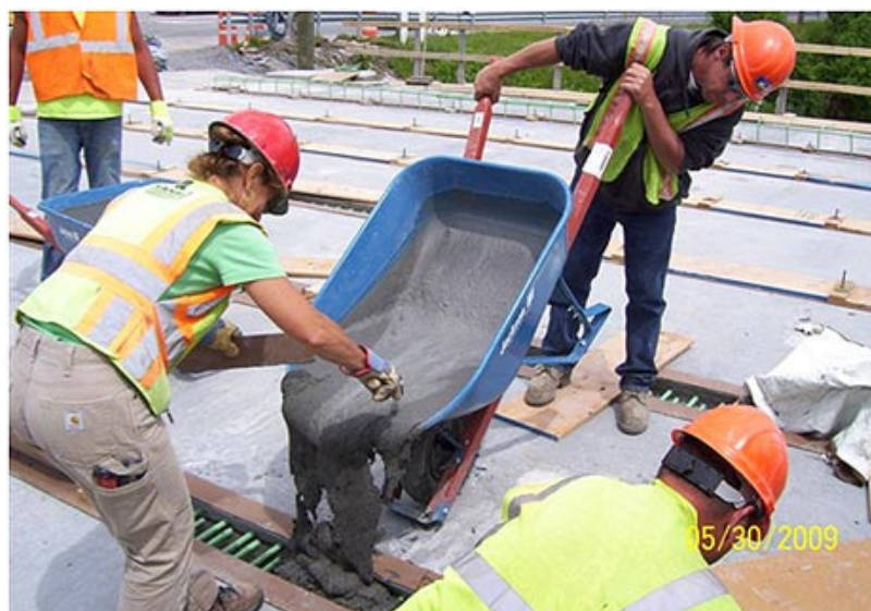
Obrázek 52 Betonáž podélného spoje pásnic dvou T-nosníků [117].
