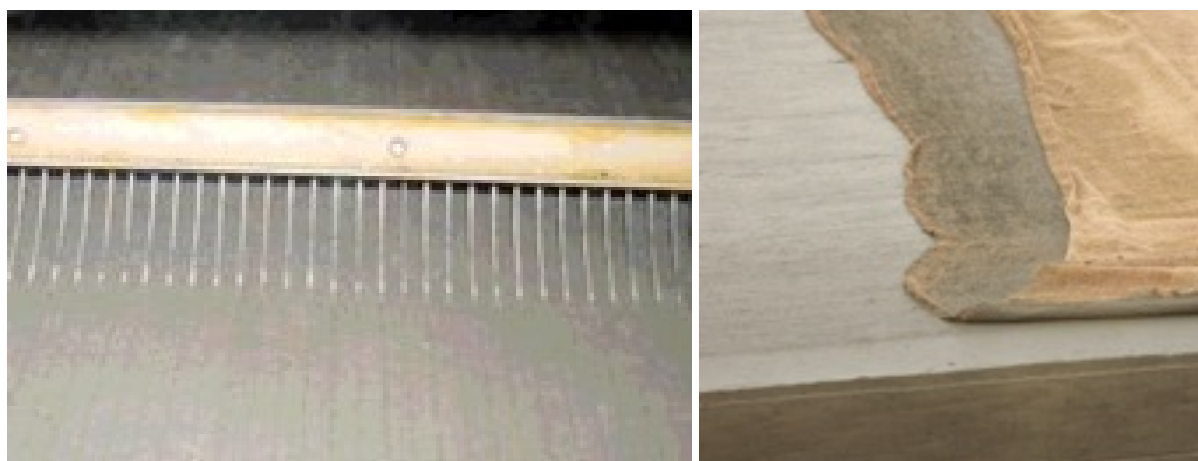
Obrázek 35 Vlevo úprava povrchu striáží, vpravo taženou jutou [84].
