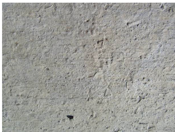
Obrázek 82 Povrch přímo poježděné mostovky z vláknobetonu po uvedení do provozu (vlevo bod B01, vpravo bod B04).
