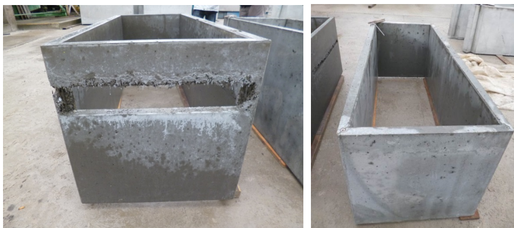
Obrázek 120 Vlevo nezdařilý prostorový dílec, kdy vlivem interakce drátkobetonu s prutovou konstrukcí výztuží došlo k nedokonalému probetonování. Vpravo zdařilý dílec získaný po optimalizaci receptury a postupu ukládání směsi.
