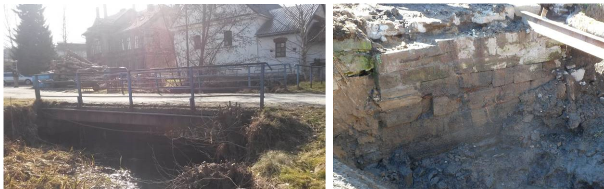
Obrázek 75 Původní konstrukce. Vlevo boční pohled na most, vpravo opěrná zeď po odstranění mostu.
