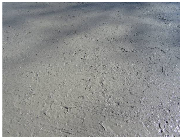
Obrázek 79 Vlevo vyrovňování povrchu pomocí latě. Vpravo povrch čerstvého vláknobetonu po provedení povrchové úpravy.
