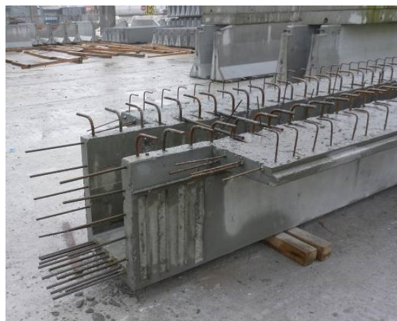
Obrázek 101 Vlevo pohled na koncovou část Omega nosníku. Vpravo příčný řez Omega nosníkem s označením výztuže a rozměrů.
