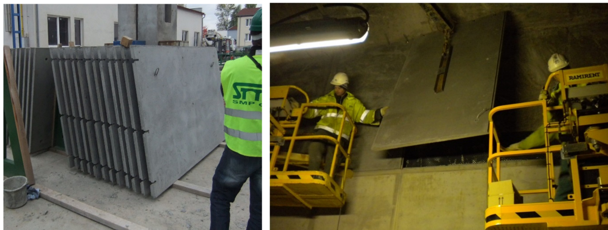
Obrázek 68 Vlevo panely na skládce, vpravo montáž panelů [145].
