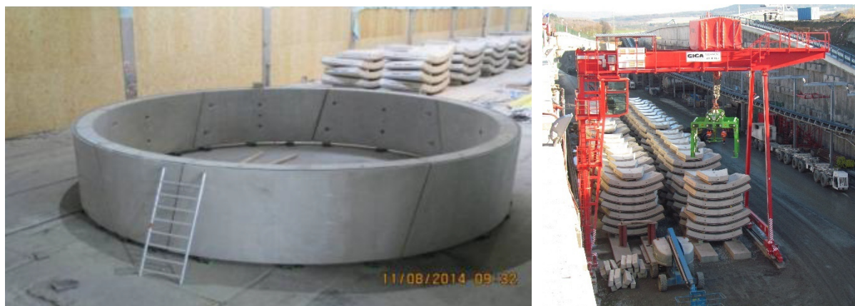
Obrázek 65 Vlevo zkušební sestavení jednoho prstence ostění Ejpovických tunelů [140]. Vpravo skládka segmentů připravených k osazení [141].
