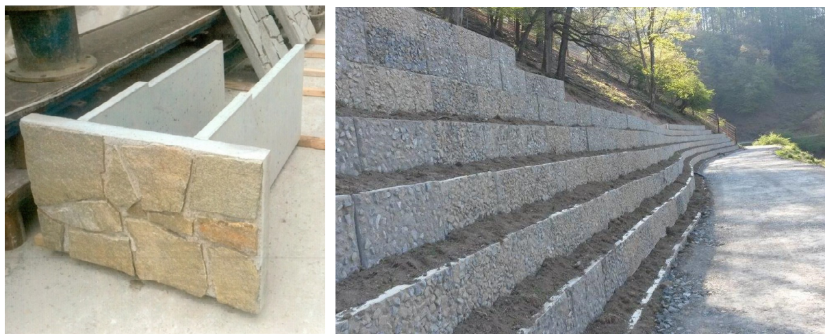
Obrázek 61 Vlevo prefabrikát opěrné zdi z vláknobetonu [125], vpravo opěrná zeď v Lánské oboře [126].
