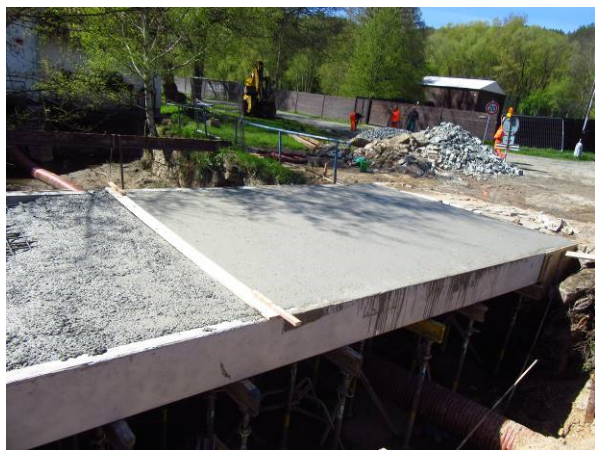
Obrázek 79 Vlevo vyrovňování povrchu pomocí latě. Vpravo povrch čerstvého vláknobetonu po provedení povrchové úpravy.
