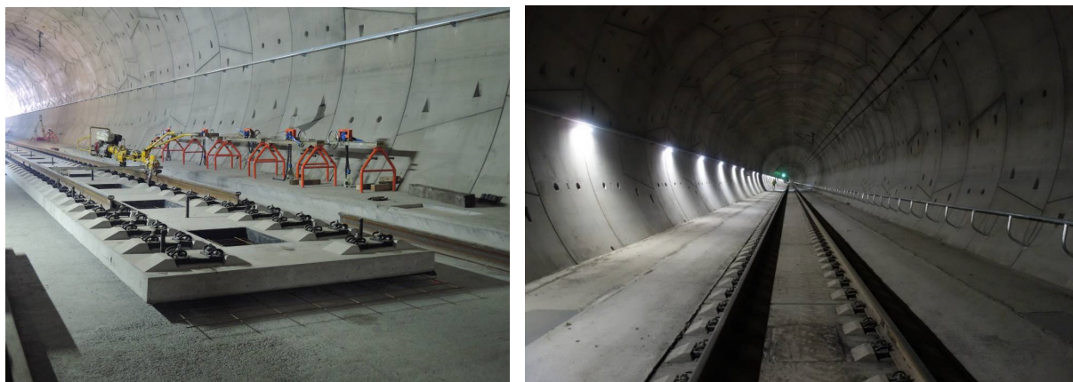
Obrázek 74 PJD v tunelech Ejpovice – vlevo instalace desek, vpravo dokončená konstrukce [154].
