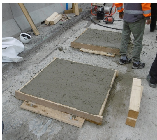
Obrázek 96 Vlevo mostovka po odfrézování horní vrstvy. Vpravo zkušební úseky nabetonávky.
