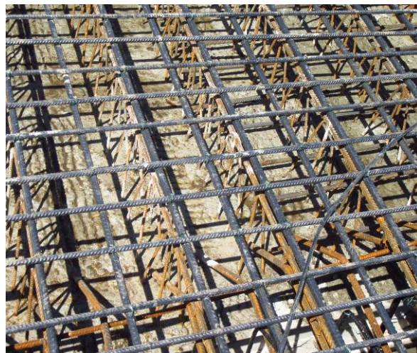
Obrázek 78 Vlevo celkový pohled na most před zhotovením monolitické dobetonávky z vláknobetonu. Vpravo detail výztuže, horní výztuž desky je opatřena ochranným termoplastickým povlakem.
