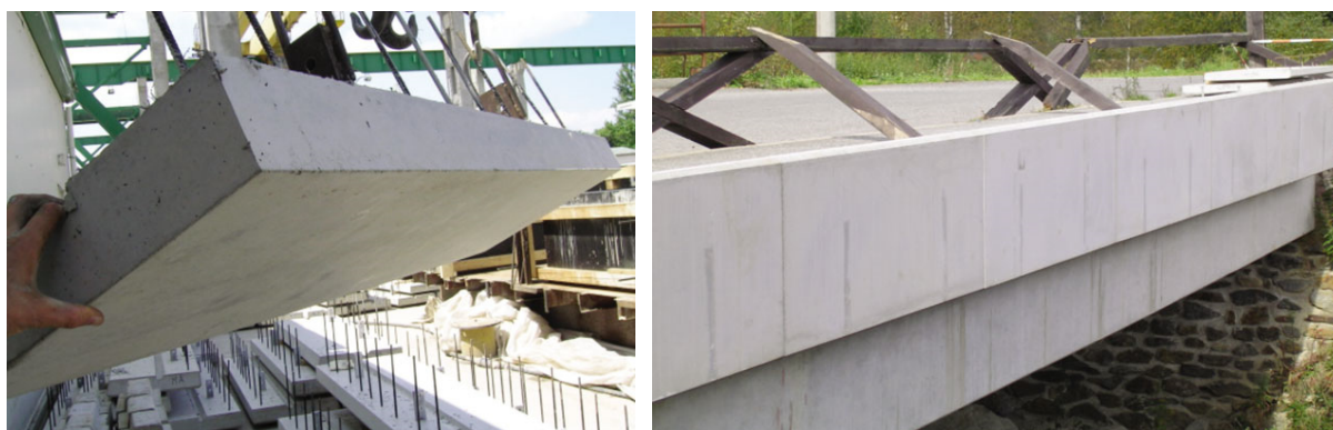
Obrázek 59 Vlevo povrch římsového prefabrikátu po odformování, vpravo prefabrikáty osazené na mostní konstrukci [123].
