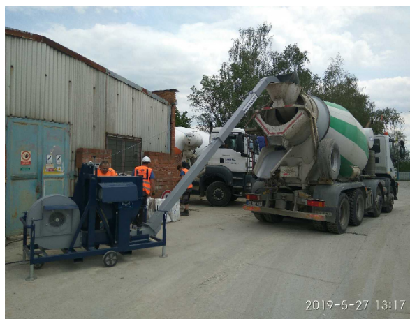
Obrázek 95 Vlevo složený rozdružovač. Vpravo dávkování drátků do autodomíchávače.
