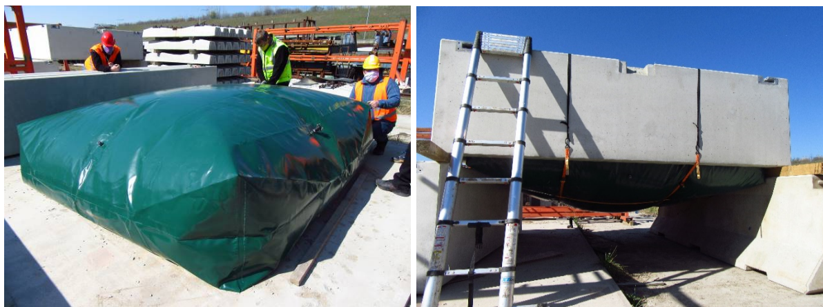
Obrázek 136 Napouštění a osazení zkušebního vzduchového vaku.
