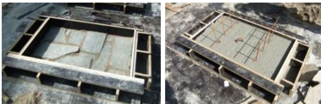
Obrázek 2-60 Kamenné obložení umístěné do formy (vlevo) a čelní stěna pilotního dílce po betonování (vpravo)
