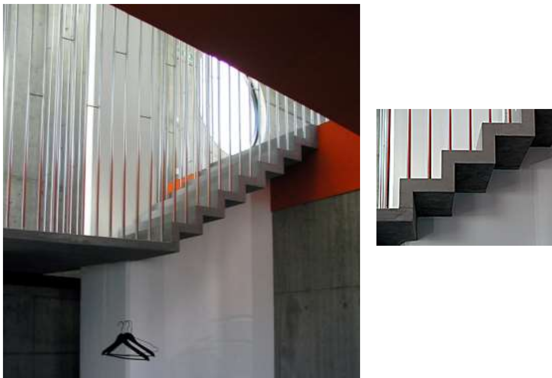
Obrázek 3-16 Schodiště z materiálu CRC, Brunsbjergvej, Århus, Dánsko
