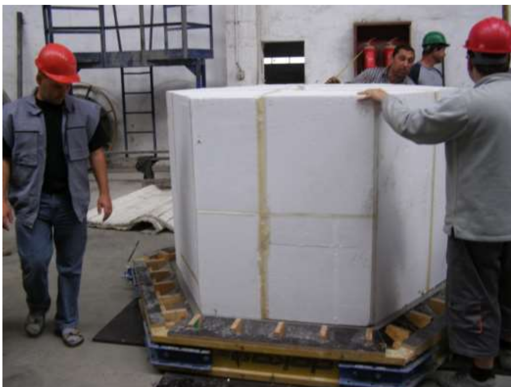
Obrázek 2-48 Osazení polystyrénového jádra
