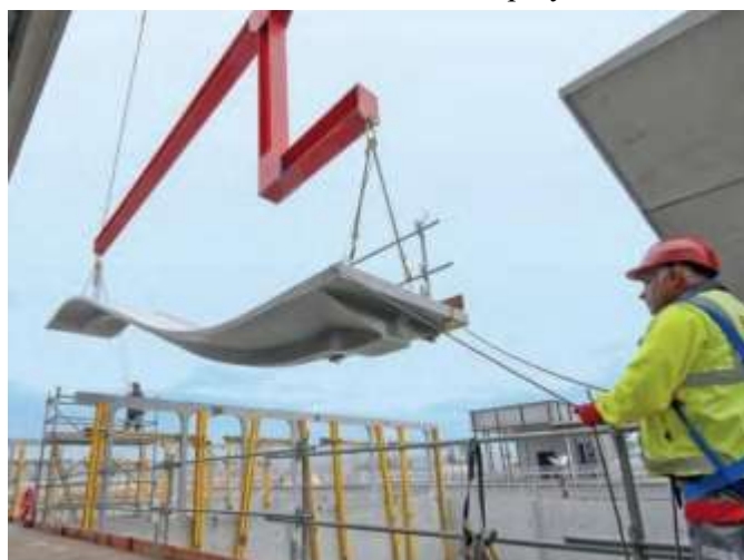
Obrázek 3-14 Manipulace se skořepinou na stavbě
