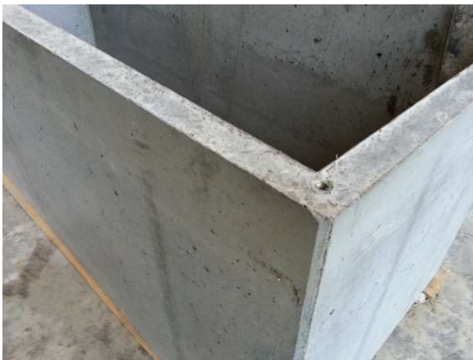
Obrázek 3-34 Detail stolku z UHPC se závitem pro transportní úchyt
