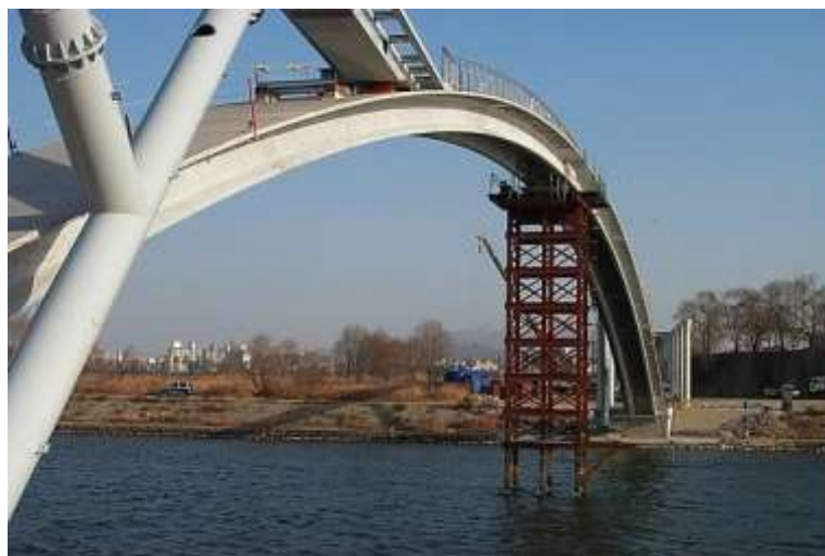
Obrázek 3-3 Pěší lávka „Most míru“ s provizorním podepřením při výstavbě
