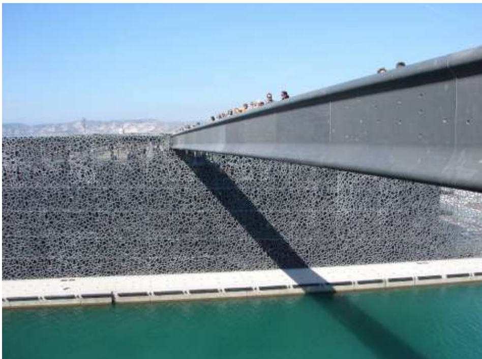
Obrázek 3-22 Pohled na lávku z UHPC a UHPC fasádní panely muzea MuCEM
