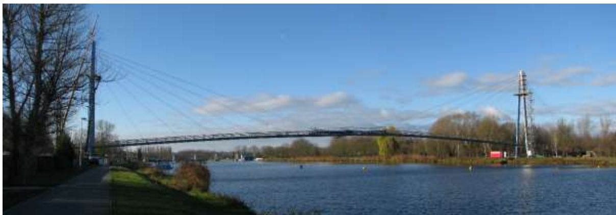
Obrázek 3-10 Lávka z UHPC v Čelákovících [19]
