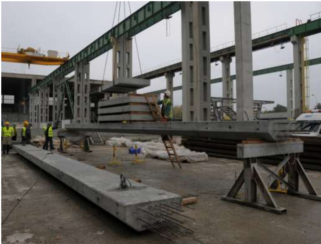
Obrázek 2-81 Osazování čtvrtého panelu při zatěžovací zkoušce
