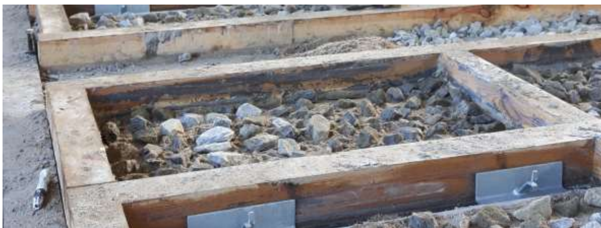
Obrázek 2-62 Sériová výroba dílců opěrné stěny – příprava pohledové strany
