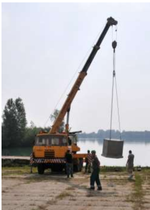
Obrázek 2-42 Transport tělesa jeřábem na vodu
