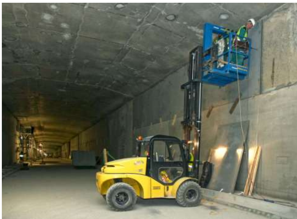
Obrázek 2-52 Osazování obkladových desek v tunelu [4]
