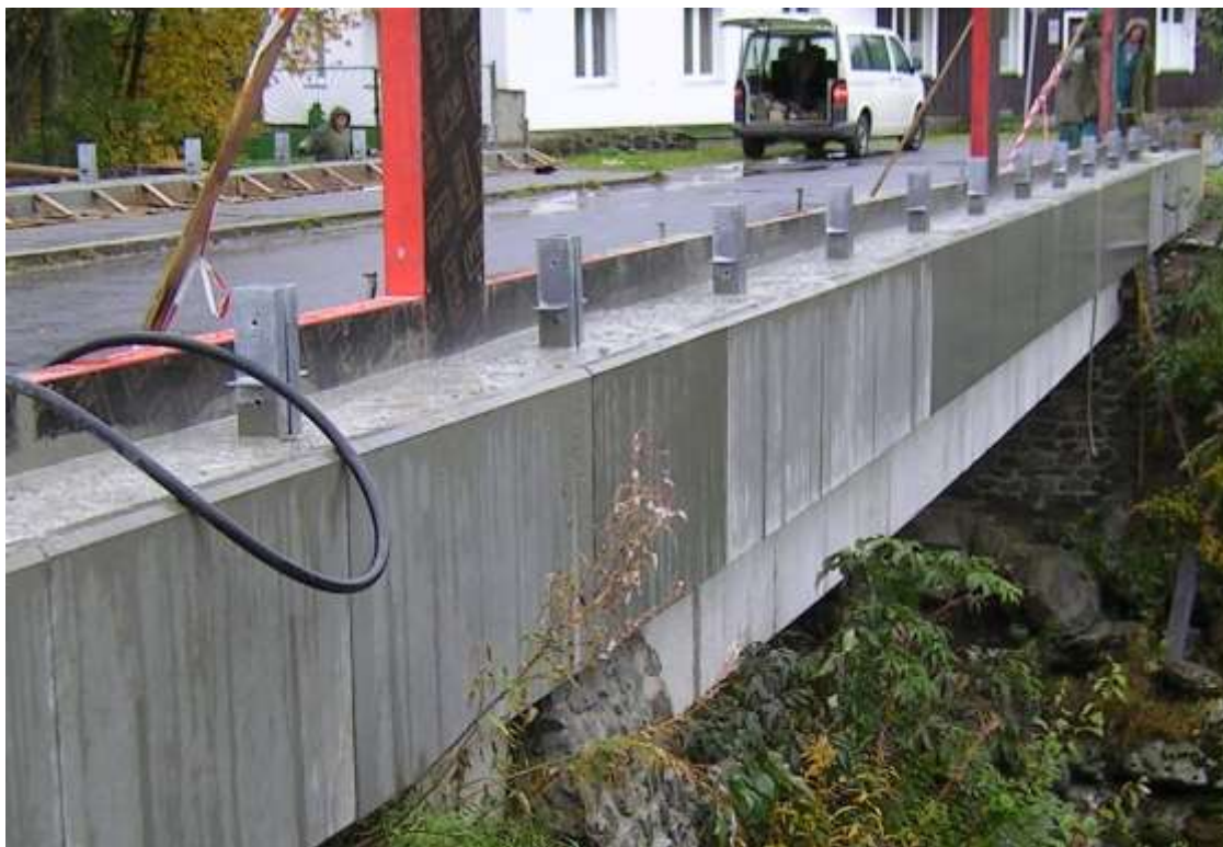
Obrázek 2-39 Vláknobetonové mostní římsy
