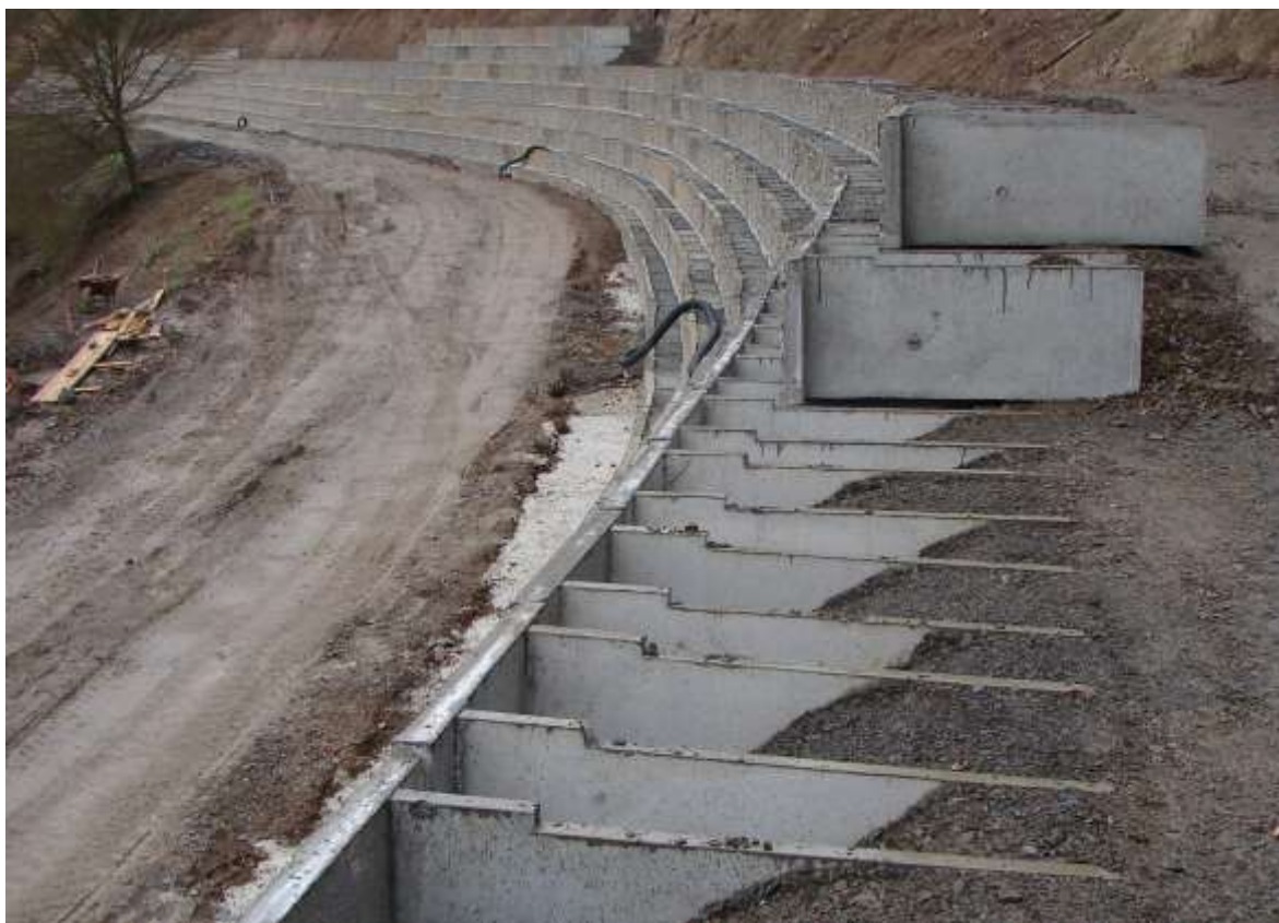
Obrázek 2-63 Smontovaná stěna
