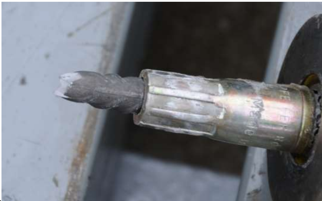
Obrázek 2-83 Přetržená výztuž po zkoušce kotevních prvků zábradlí
