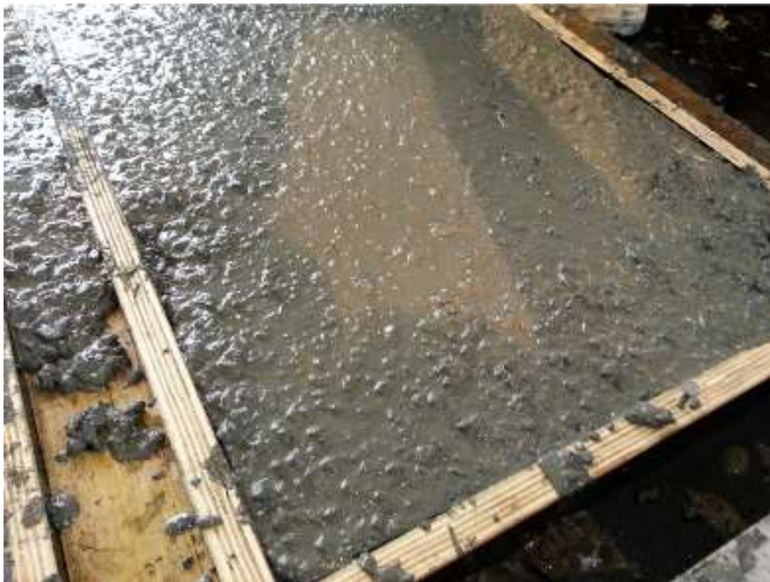
Obrázek 3-25 Výroba desky pro experimentální ověření únosnosti
