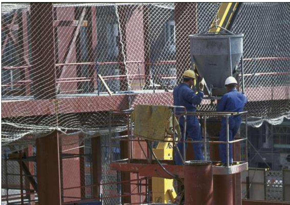
Obrázek 3-19 Betonáž ocelobetonových sloupů z Ductalu
