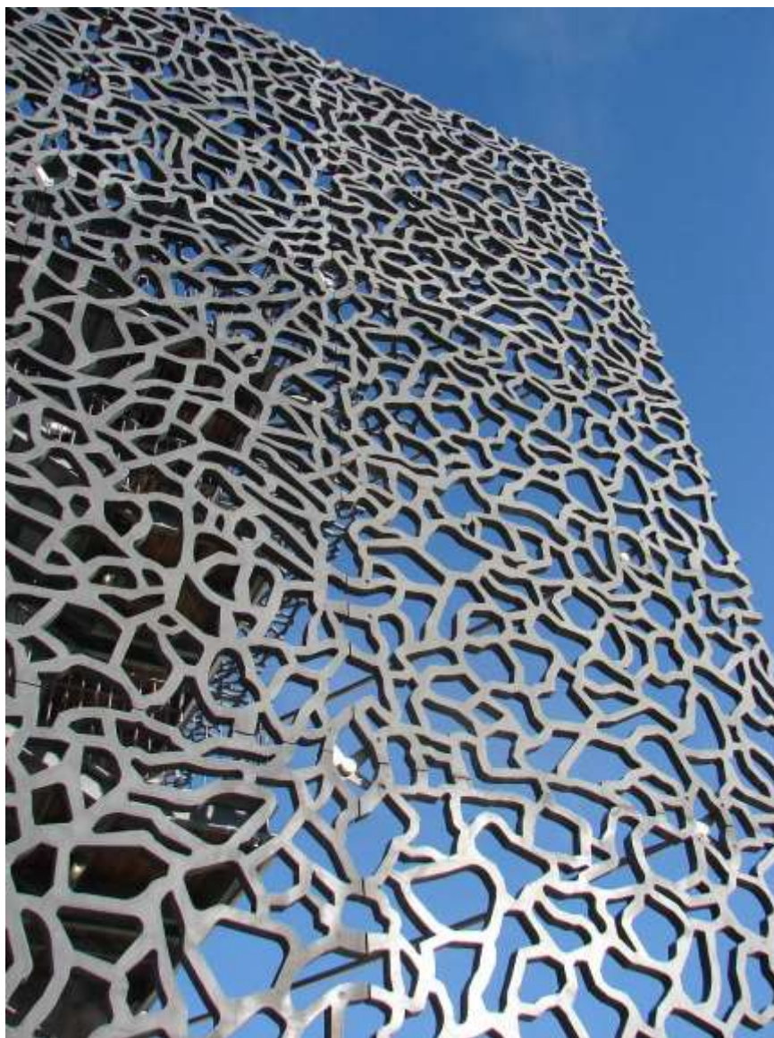
Obrázek 3-23 Fasáda sestavená z UHPC perforovaných panelů
