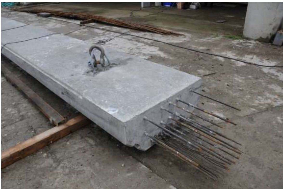
Obrázek 2-79 Čelo prefabrikátu a zvedací oko
