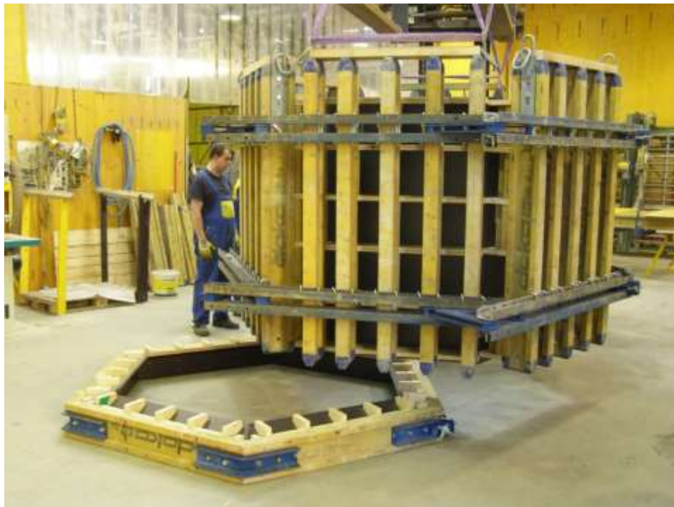
Obrázek 2-46 - Bednění okrajového lemu a pláště
