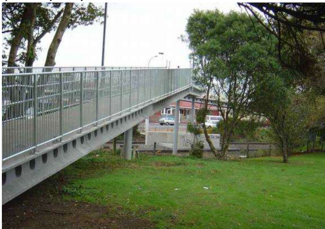
Obrázek 3-4 Lávka s nosníky z UHPC
