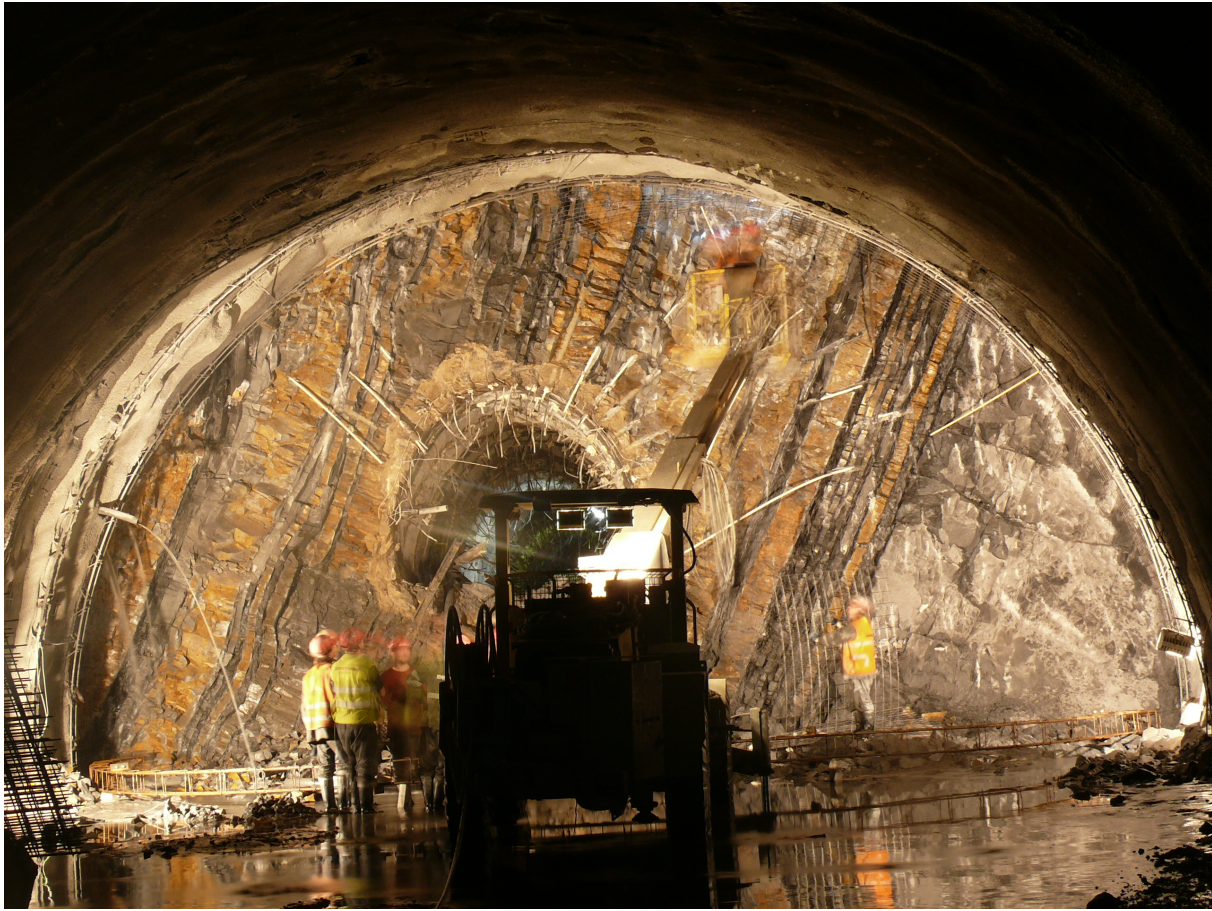
Obr. 2 – Čelba kaloty dvoupruhového tunelu ve skaleckých křemencích
