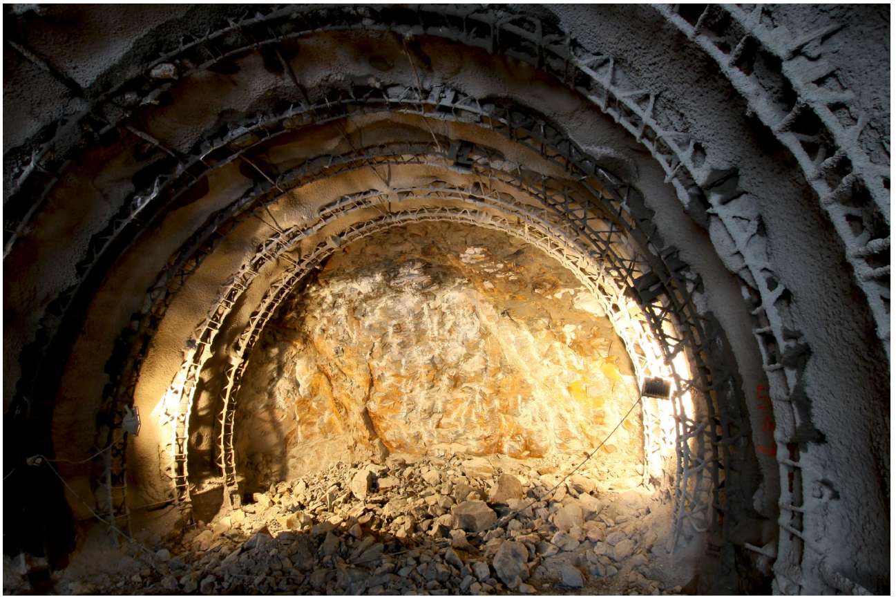
Obr. 3 – Pohled na čelbu při ražbě vinného sklepa
