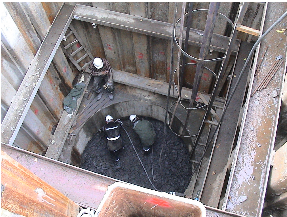
Obr.8 – Fotografie z hloubení šachty V1 na Císařském ostrově
