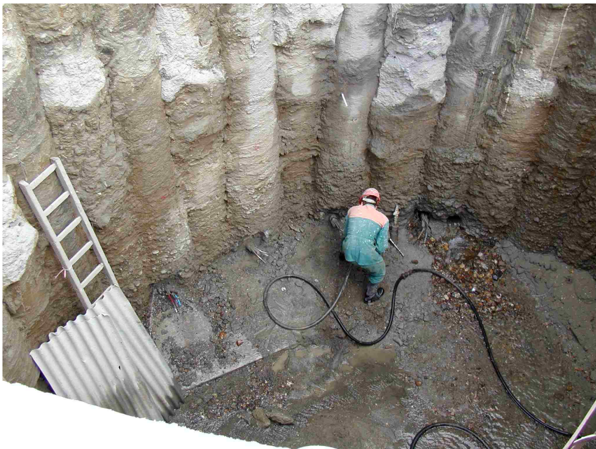
Obr. 5 – Fotografie kotvení v těžní šachtě Troja
