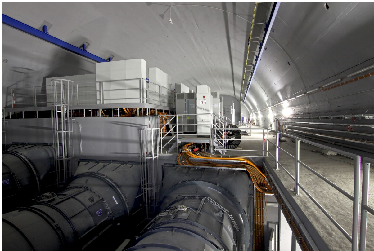
Obr. 8 – Porovnání prostoru strojovny po jejím vyražení a v definitivním stavu
