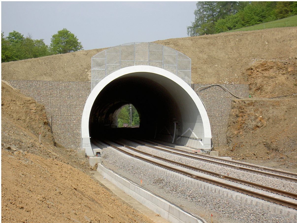
Obr. 6 – Pohled na portál tunelu Hněvkovský I
