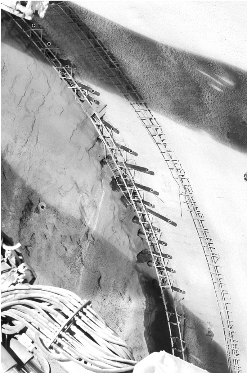
Obr. 3 – ochranný deštník ze svorníků IBO 32L
