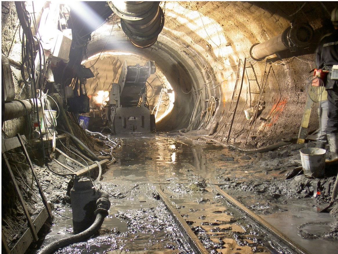
Obr. 4 – Teoretický výrub výhybny má plochu 18,7 m 2
