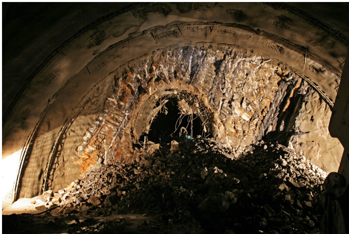
Obr. 2 – Fotografická dokumentace čelby kaloty tunelu
