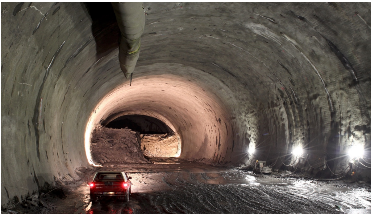
Obr. 3 – Strojovna vzduchotechniky po vyražení a v definitivním stavu
