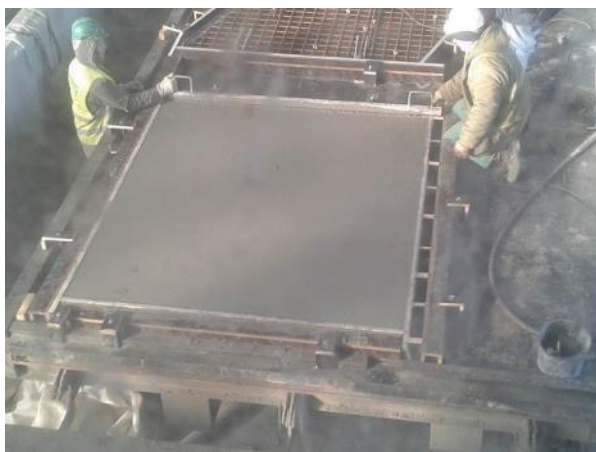
Obr. 98 Úprava horního povrchu deskového dílce z důvodu zahlazení drátků.
