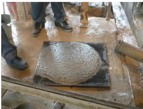
Obr. 96 Zkouška konzistence čerstvého vysokohodnotného betonu.
