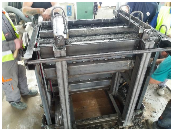
Obr. 135 Betonáž do uzavřené formy – celá forma.
