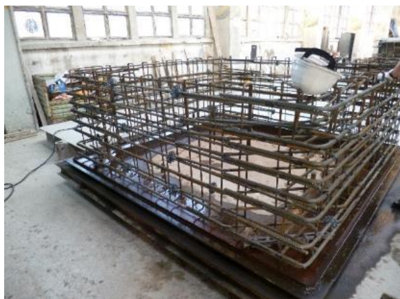
Obr. 140 Příprava výztužného armokoše.
