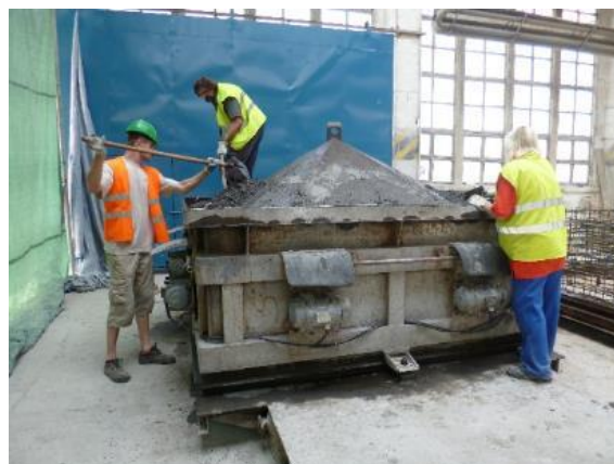
Obr. 141 Betonáž rámu.
