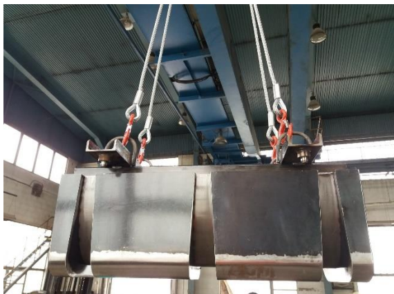
Obr. 134 Betonáž do uzavřené formy – vnitřní jádro.
