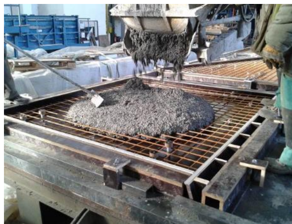
Obr. 97 Ukládání čerstvého betonu do bednění.
