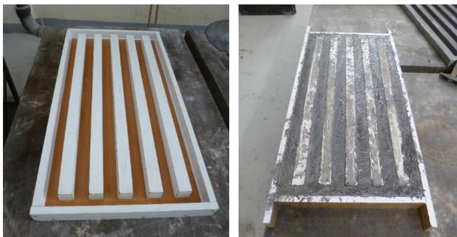
Obr. 73 Vlevo připravená forma, vpravo vybetonovaná deska.
