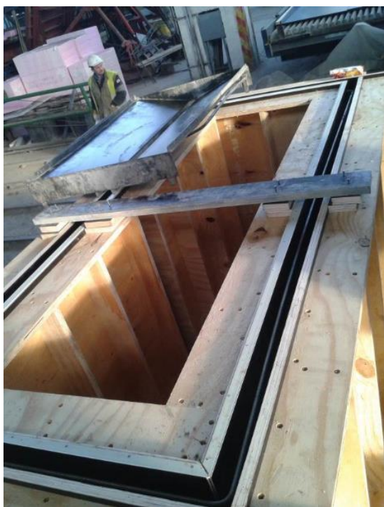
Obr. 100 Bednění pro betonový stůl.
