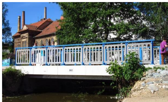
Obr. 85 Osazení dílců zábradlí na mostě v obci Sázava.
