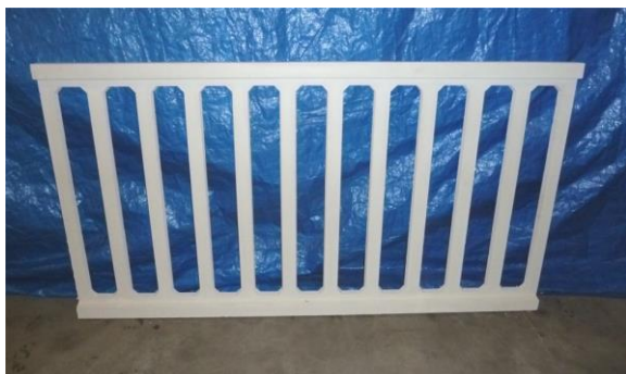
Obr. 84 Ukázka výplně zábradlí z vysokohodnotného betonu.
