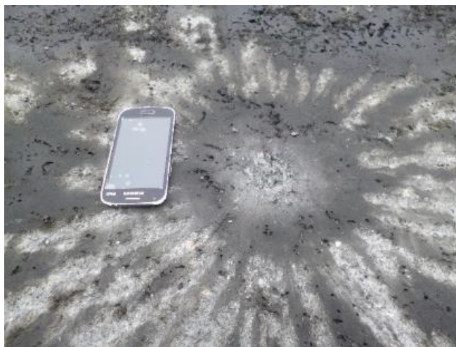
Obr. 143 Poničený vnější povrch po výbuchu minometného granátu.
