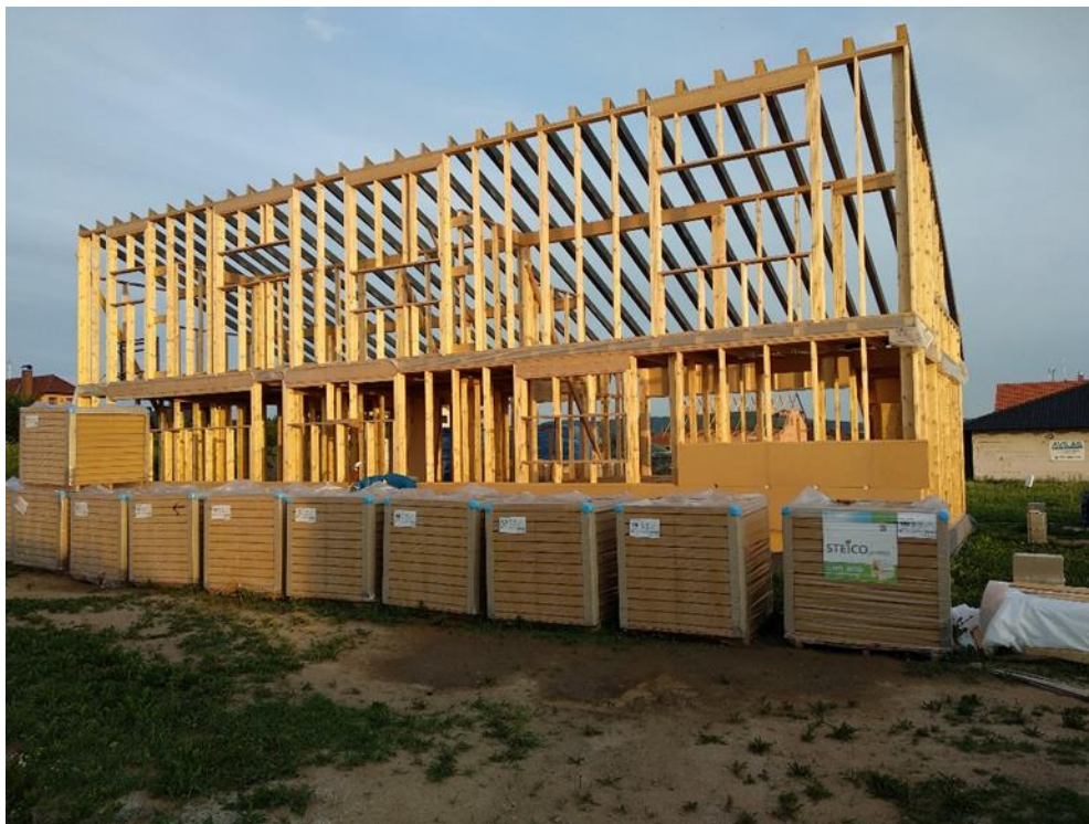
Obr. 3: Konstrukce moderní dřevostavby
