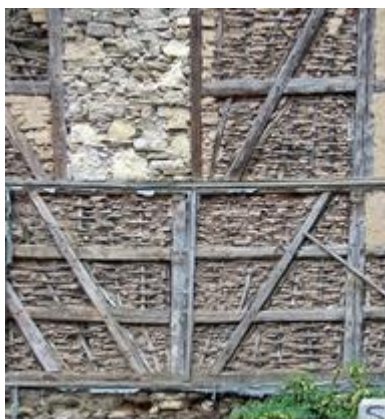
Obr. 55: Historická konstrukce se zazděným okenním otvorem
