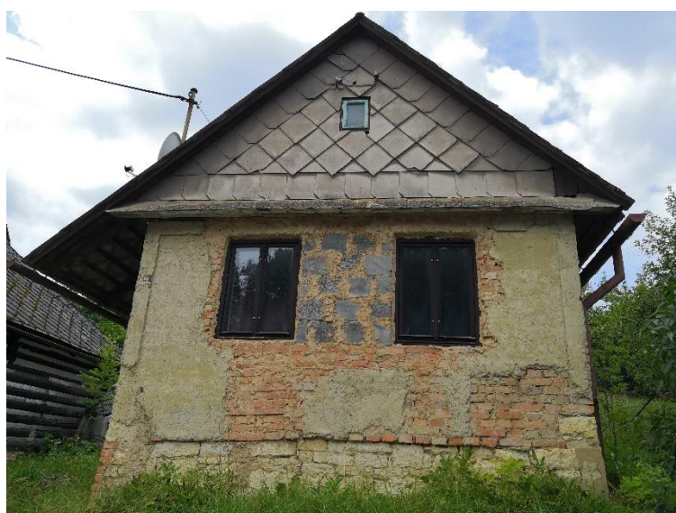
Obr. 56: Cihelná konstrukce vyspravená pórobetonovými tvárnicemi
