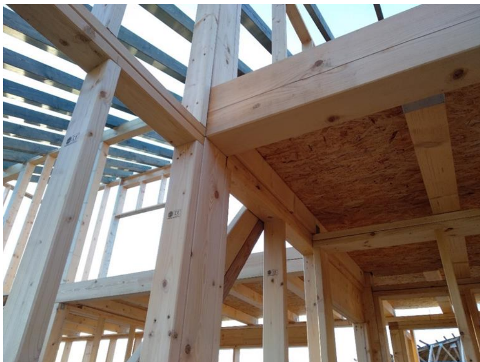
Obr. 11: Propojení svislých a vodorovných prvků
