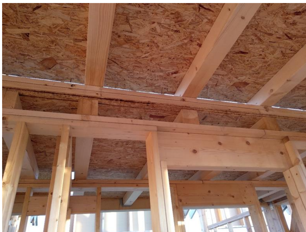
Obr. 12: Příklad využití OSB desek
