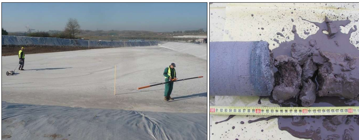
Obr. 6 a 7 – Geofyzikální měření ve zkušebním poli č. 8 a detail vrtného jádra.
