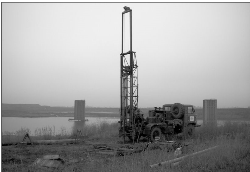
Obr. 3 Realizace vrtu HJ2, v pozadí přepadové věže.
