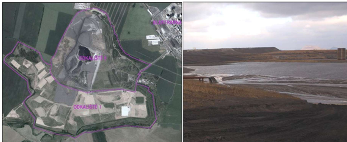
Obr. 1 a 2 – Situace zájmové stavby a plavení strusky do zbytkového jezera (v pozadí PV).
