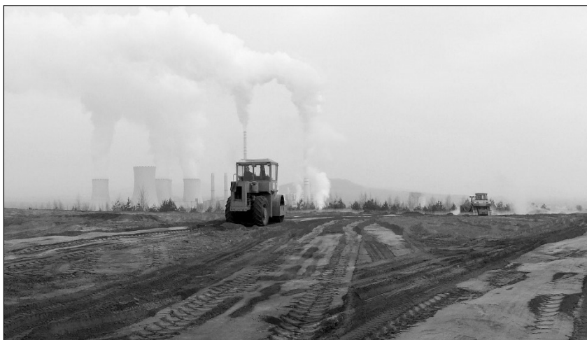
Obr. 2 Navážení a hutnění stabilizátu v zájmovém prostoru.
