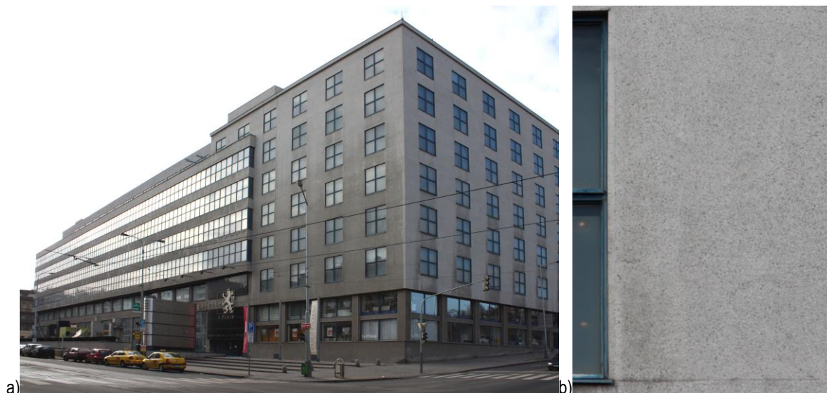
Obr. 13 a) Celkový pohled na Veletržní palác v Praze (1925 – 28); b) Detail povrchu provedeného hlazenou cementovou omítkou. (Foto K. Kroftová)
