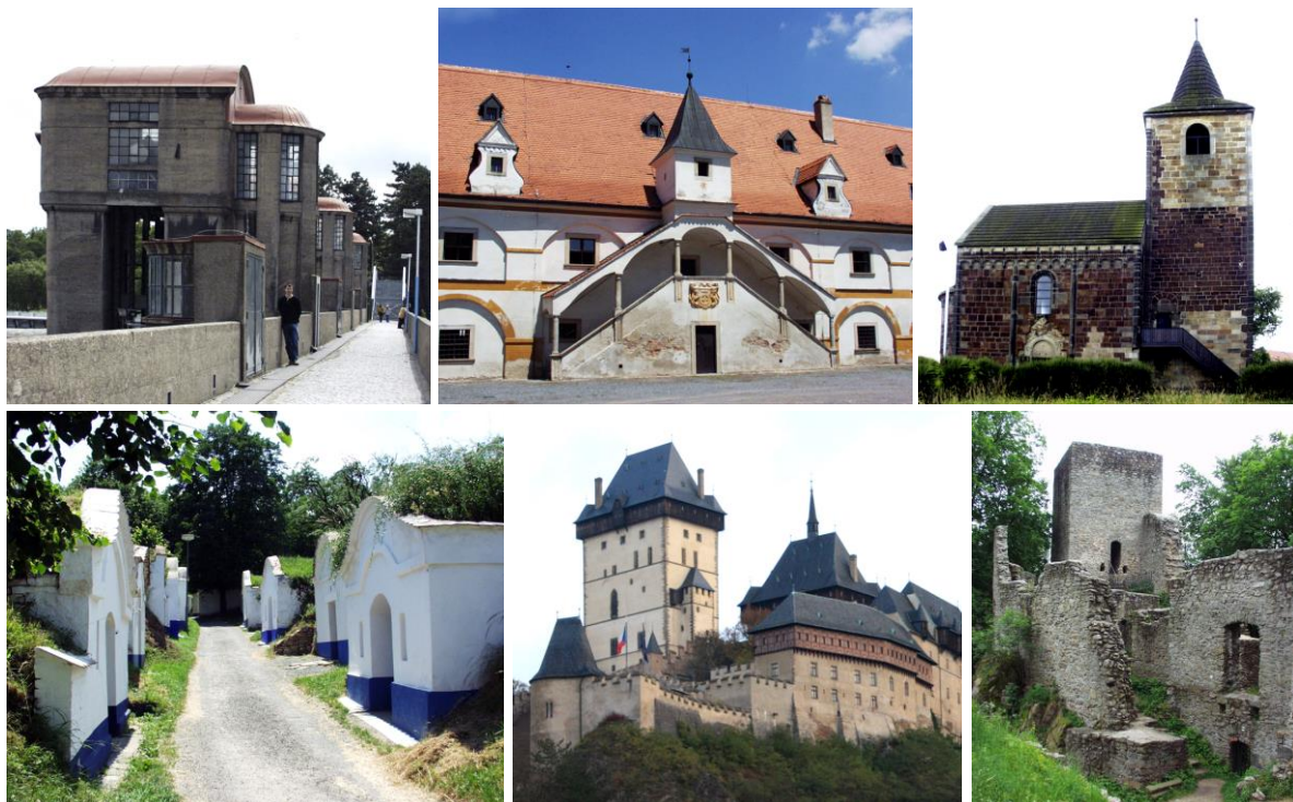
Obr. 2 Příklady historických objektů dokládající rozmanitost nemovitého památkového fondu, která zakládá na metodický pluralismus přístupu k jejich obnově: a) hydroelektrárna a regulace Labe, Nymburk (1923); b) vodní mlýn, Slup, poč. 17. století; c) románský kostel sv. Jakuba Většího ve Vrutku (13. století); d) areál historických vinných sklepů Petrov – Plzeň (18.-19. století); e) hrad Karlštejn (současný vzhled po puristické úpravě J. Mockerem, 2. polovina 19. století); f) zřícenina hradu Choustník, konec 13. století (Foto K. Kroftová)
