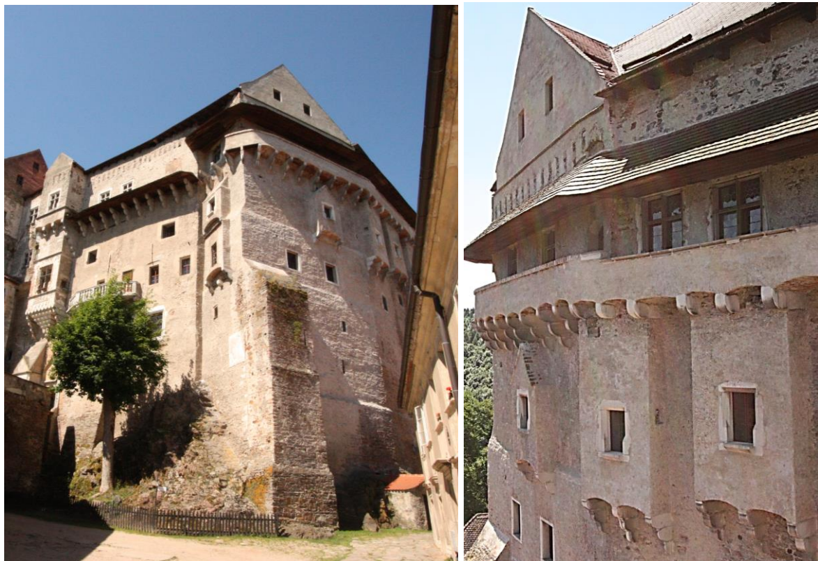
Obr. 28 Hrad Pernštejn po konzervaci provedené opakovanou aplikací vápenné vody: a) celkový pohled na průčelí; b) pohled na konsolidované omítky, 2014 (Girsa, V. et al 2009) (Foto K.Kroftová)
