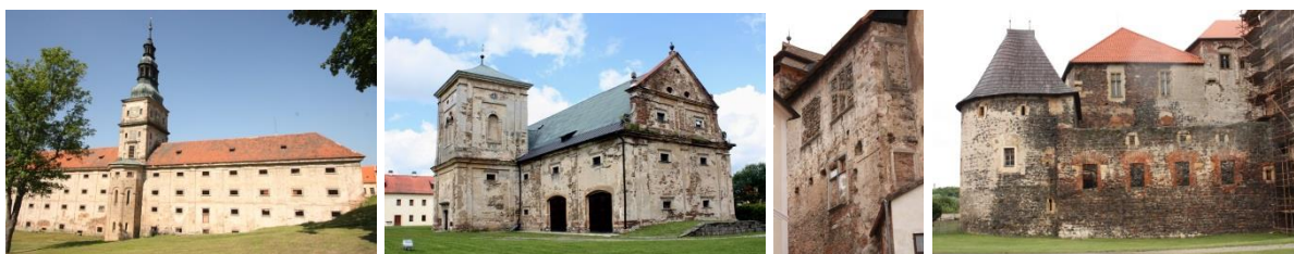
Obr. 1 Příklady památkově chráněných objektů před obnovou: a) klášter Plasy; b) klášter Teplá; c) Hrad Bečov nad Teplou; d) hrad Švihov (Foto K. Kroftová)
