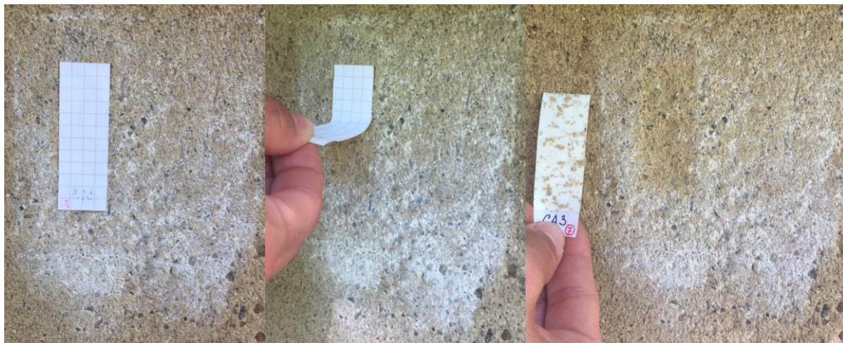
Obr. 138 Provádění „Scotch Tape“ testu in-situ – (zleva) předem připravené a označené lepicí pásky jsou přitlačeny k povrchu materiálu a poté opatrně sejmuty (kolmý úhel odtrhu) a umístěny do transportního sáčku
