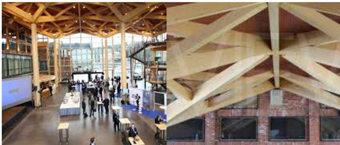
Obr. 1.1.1: Konstrukce stropu Forest Hall
