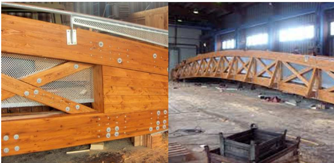
Obr. 1.1.6: Lávka přes Svitavu v Brně
