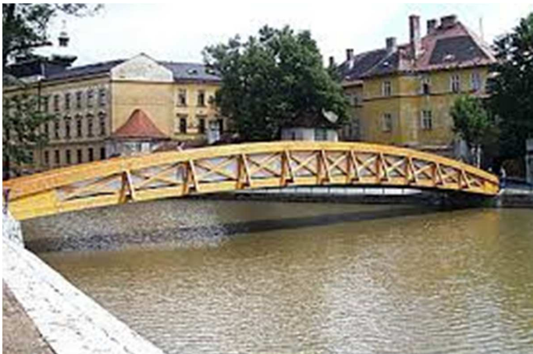
Obr. 1.1.5: Lávka v Českých Budějovicích
