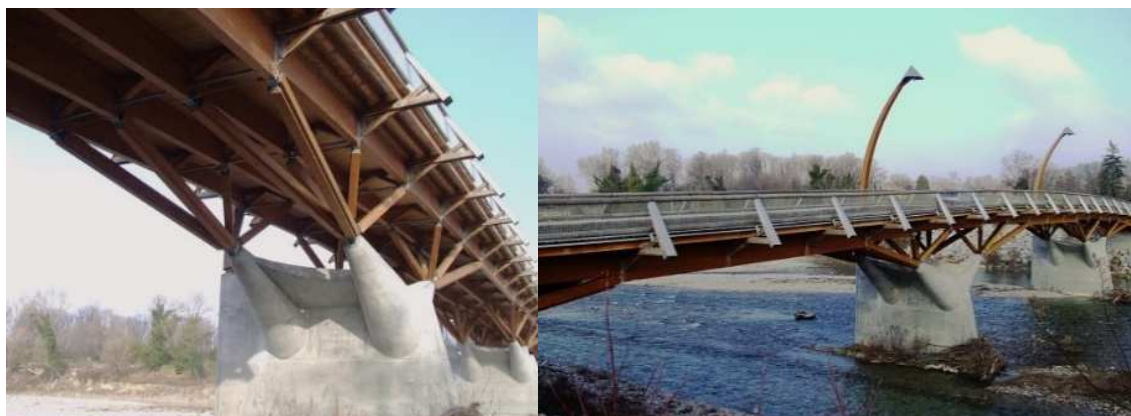
Obr. 1.1.2: Most přes řeku Drôme ve městě Crest.
