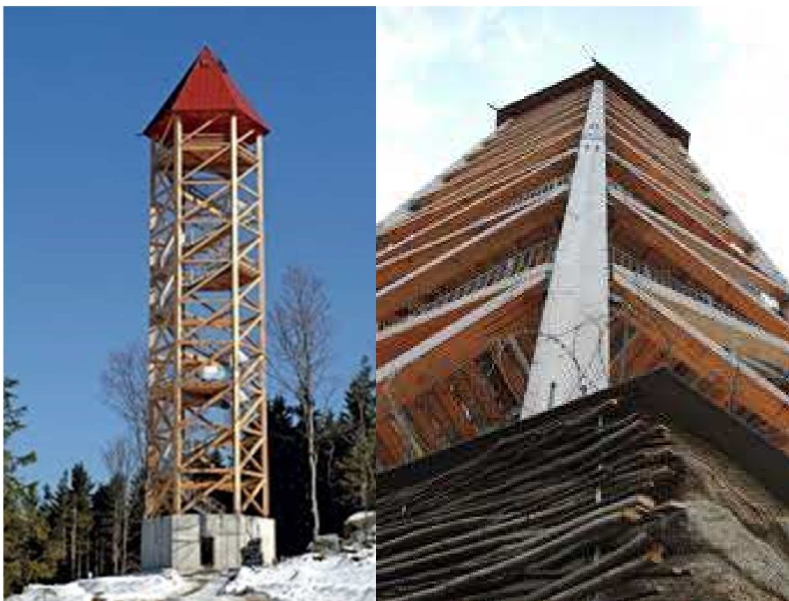
Obr. 1.1.10: Rozhledna ve Valtínově
