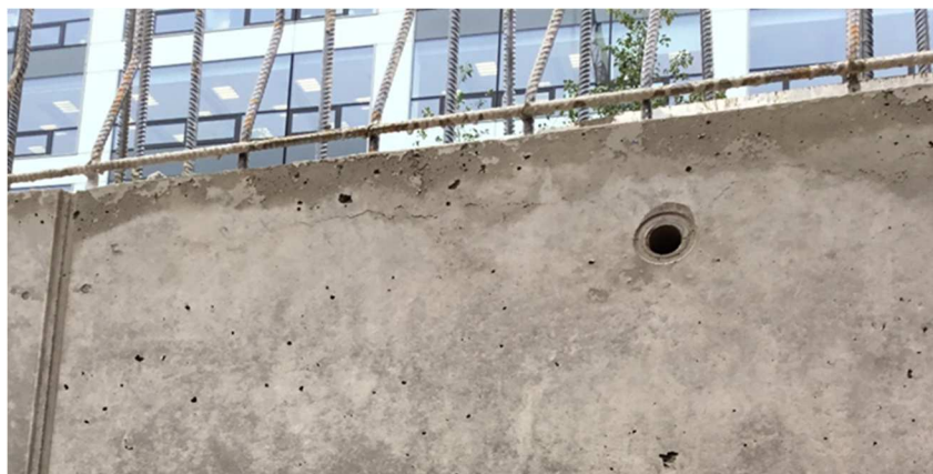
Obr. 4.1: Důsledek smrštění od vysychání.
