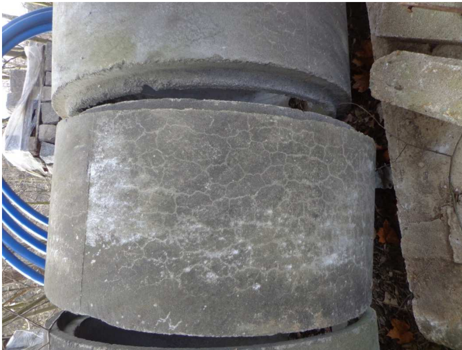
Obr. 3.1 Rozvoj trhlin vlivem ASR na betonovém prvku.
