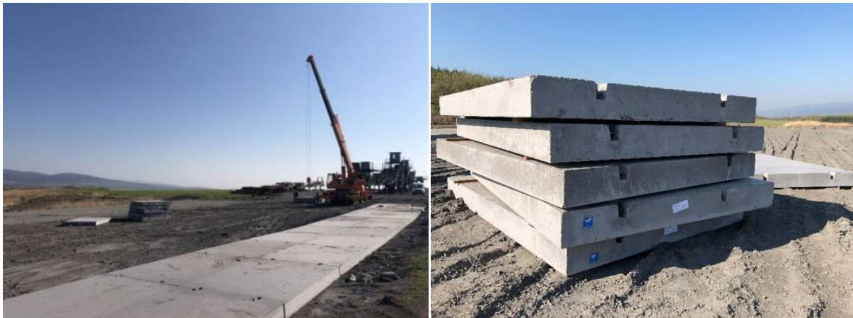
Obr. 82: Silniční panely z pojiva SORFIX, Prunéřov 2019
