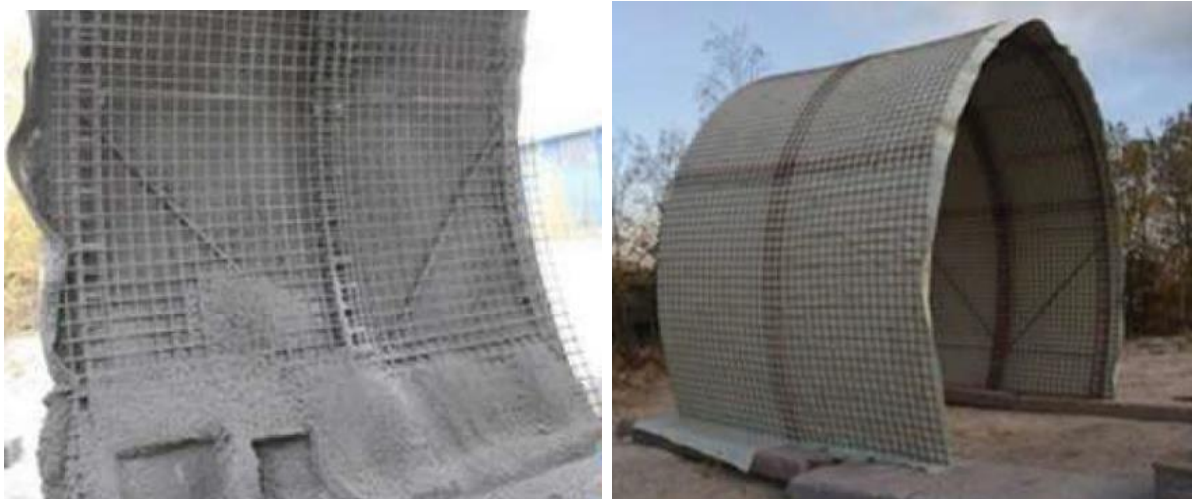
Obr. 86: Aplikace stříkaného betonu z pojiva SORFIX, 2019, (Šmilauer et al., 2021)
