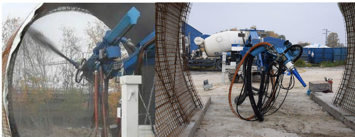
Obr. 85: Příprava aplikace stříkaného betonu z pojiva SORFIX, 2019, (Šmilauer et al., 2021)
