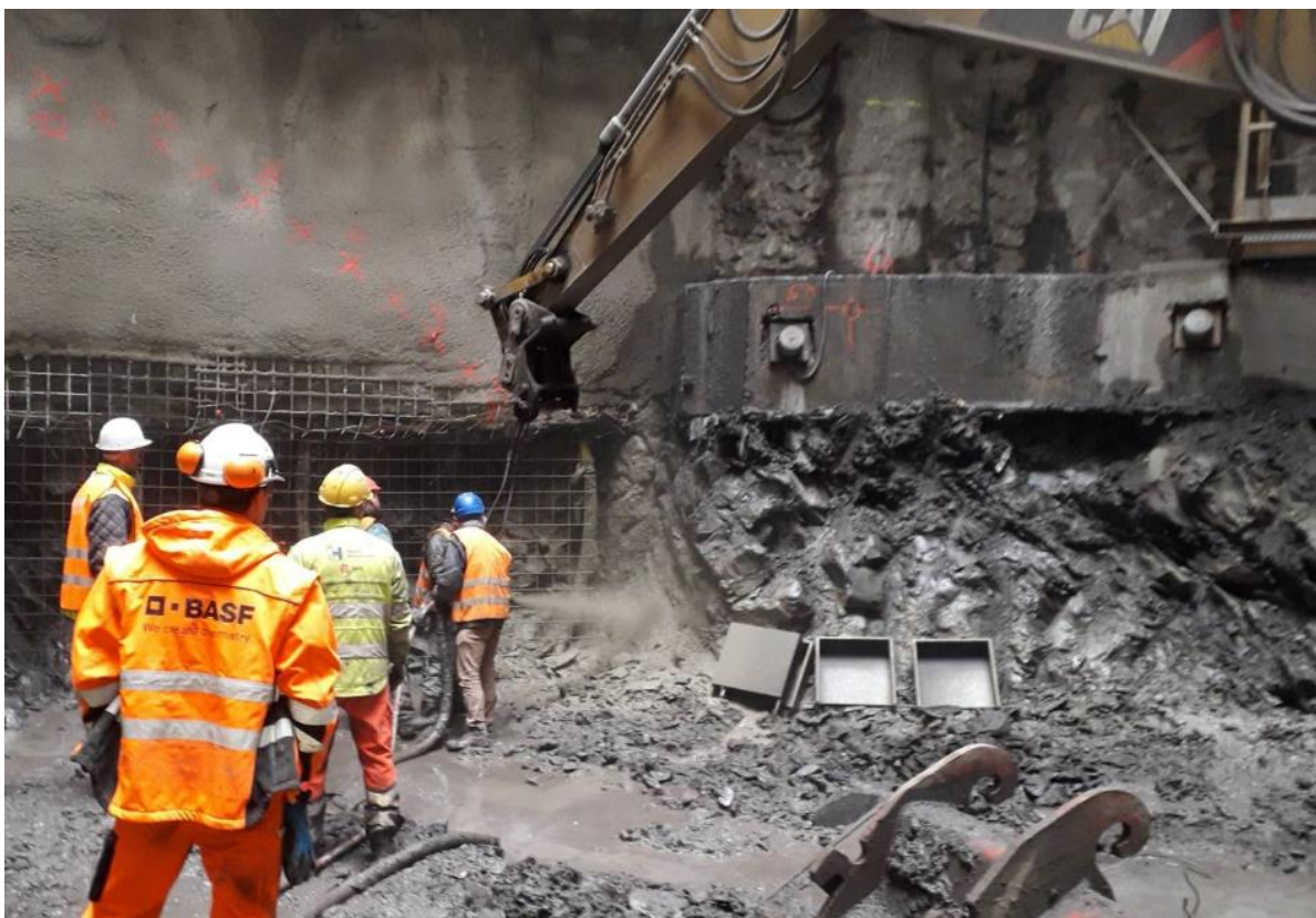
Obr. 88: Fotografie ze stavby průzkumné štoly metra D s využitím pojiva SORFIX, 2020
