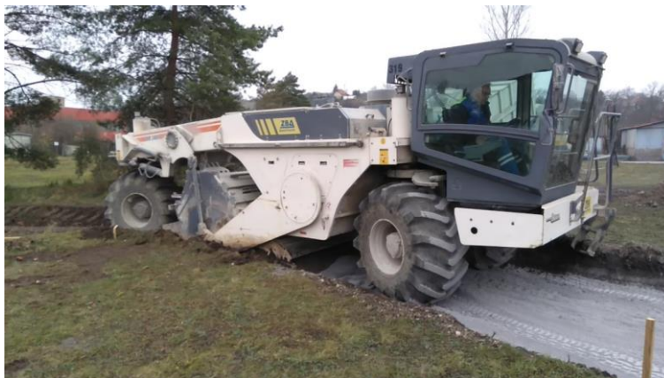
Obr. 83: Aplikace pojiva SORFIX G pomocí zemní frézy
