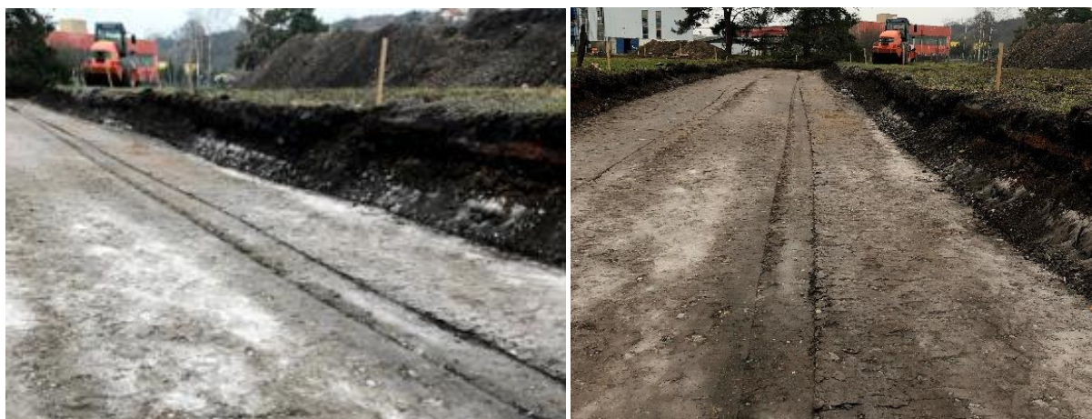
Obr. 84: Upravená zemní pláň po aplikaci pojiva SORFIX G
