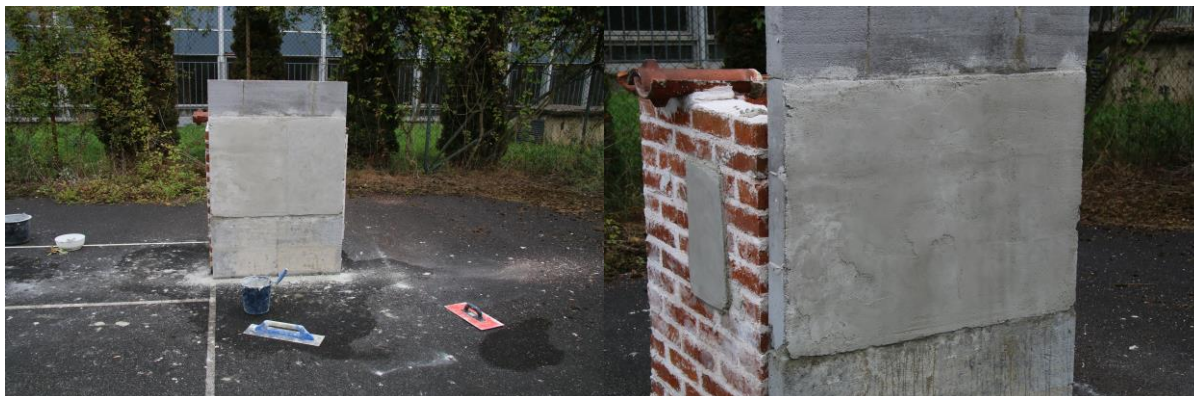
Obr. 59: Pohled na nanesenou omítku (vlevo). Detail nanesené omítky (vpravo) (stav stěny v květnu 2016).
