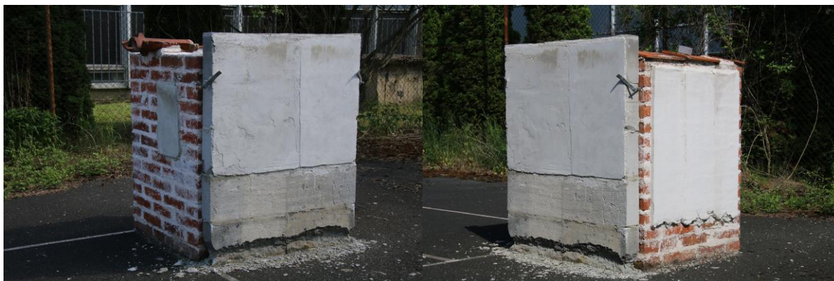
Obr. 60: Pohled na nanesenou omítku (stav v březnu 2017).
