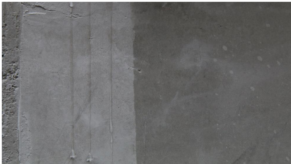
Obr. 53: Pohled na systém omítek nanesených na experimentální stěně. Hydrofobizační přísadou ošetřená část je vlevo a stékají po ní kapky při simulaci deště. Vpravo je neošetřená část, která je mokrá od simulovaného deště.
