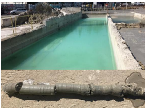
Obr. 3: Sedimentační jímka s profilem sedimentovaného kalu
