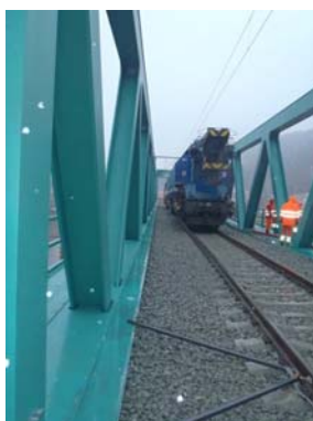
Měření interakce mostu a bezstykové koleje při zatěžovací zkoušce železničního mostu v Děčíně
