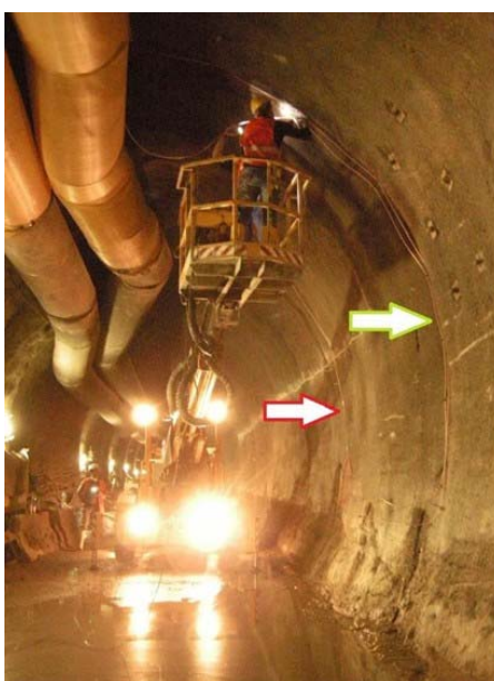
Instalace měřicích optických kabelů metro V.A
