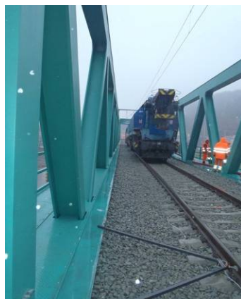
Měření interakce mostu a bezstykové koleje při zatěžovací zkoušce železničního mostu v Děčíně
