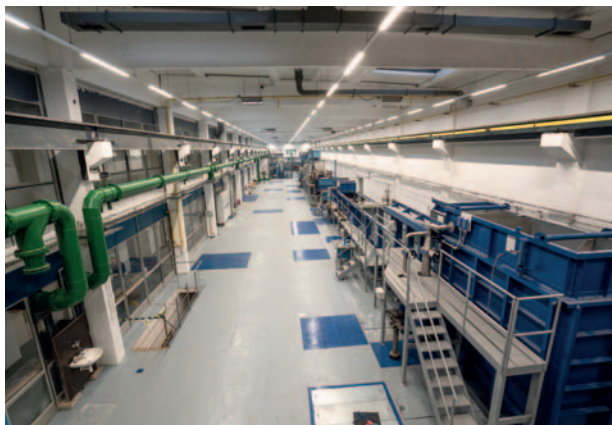
Vodohospodářská hala po rekonstrukci
